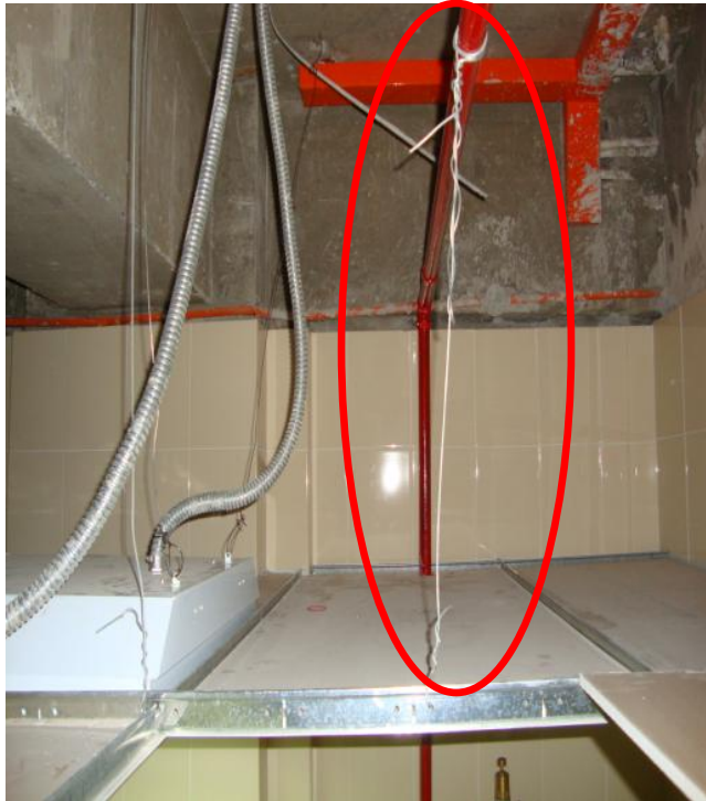
Siling Digantung Pada Paip Mekanikal
