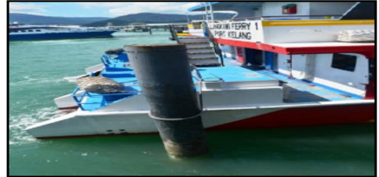
Jeti Kuah, Langkawi, Kedah - Tali Penambat Feri Disangkut Pada Tiang Guide Pile (5.9.2017)
