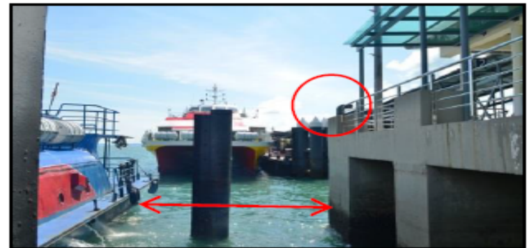
Jeti Kuah, Langkawi, Kedah - Kedudukan Bollard Di Jeti Yang Dihalang Oleh Tiang Guide Pile (5.9.2017)
