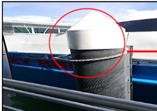
Jeti Kuah, Langkawi, Kedah - Tali Penambat Feri Disangkut Pada Tiang 'Guide Pile' (29.3.2017)
