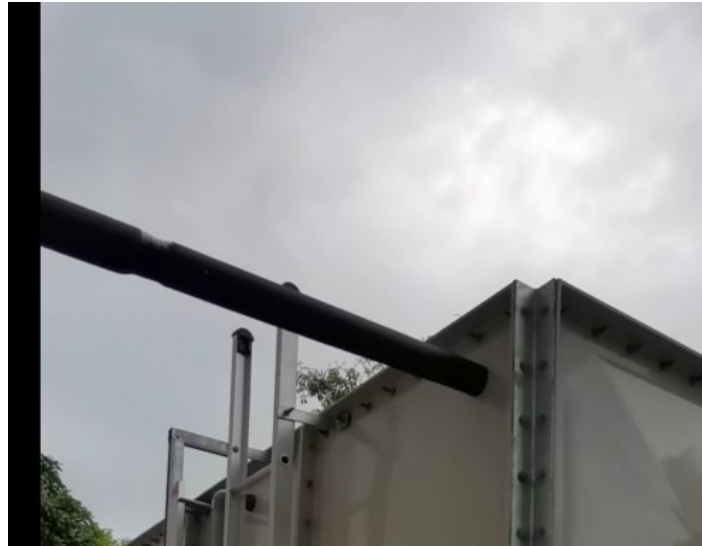
Rajah 5: Paip Disalurkan ke Tangki Dengan Balutan Penebat
