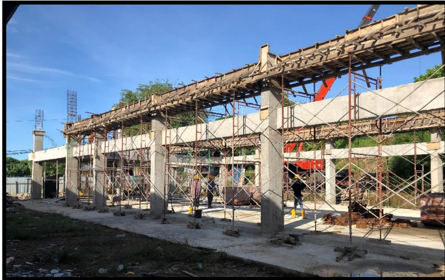
Kerja kontrik bagi rasuk aras dua bagi bengkel Kimpalan
