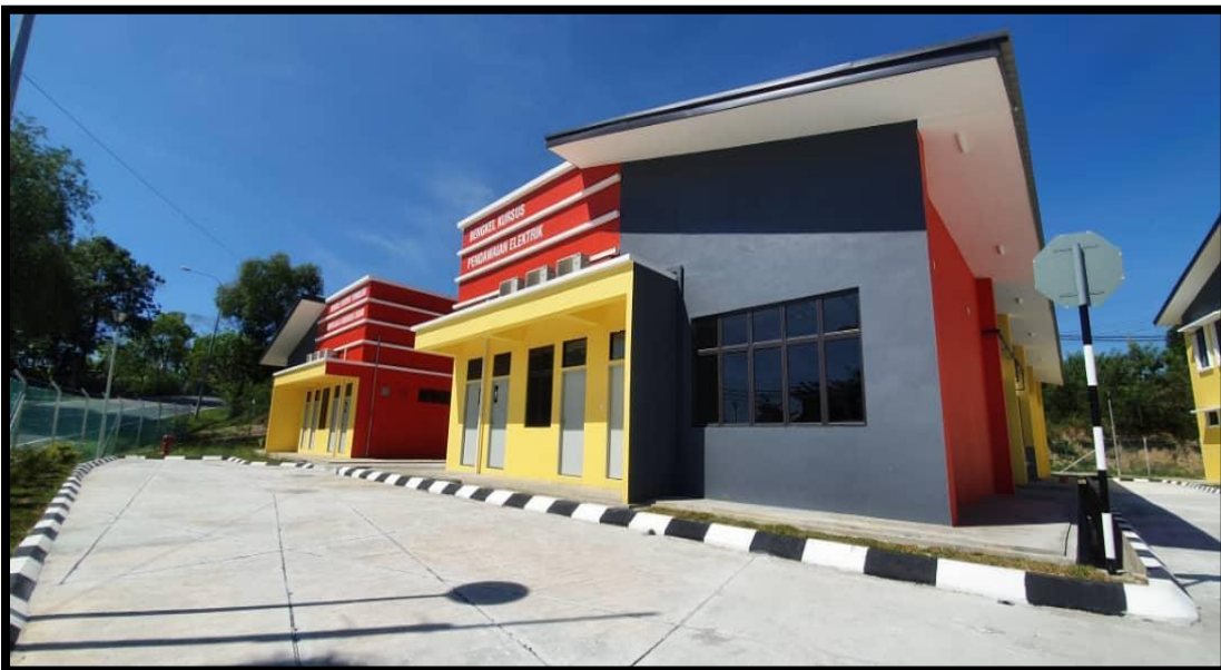
BENGKEL ELEKTRIK DAN BENGKEL KIMPALAN
