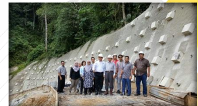
Lawatan Tapak Projek Jalan
