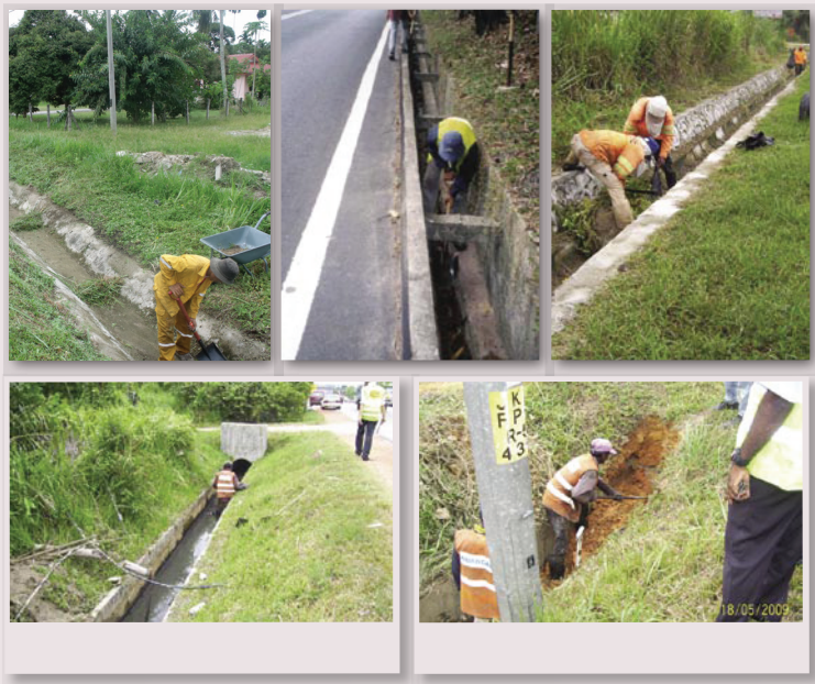
Kerja pembersihan longkang menggunakan alatan dan tenaga manusia.
