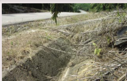
Longkang tertutup dengan sisa ladang.
