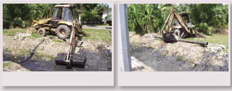
Penggunaan jentera membantu mempercepat kerja pembersihan di samping membersihkan longkang dengan sempurna.
