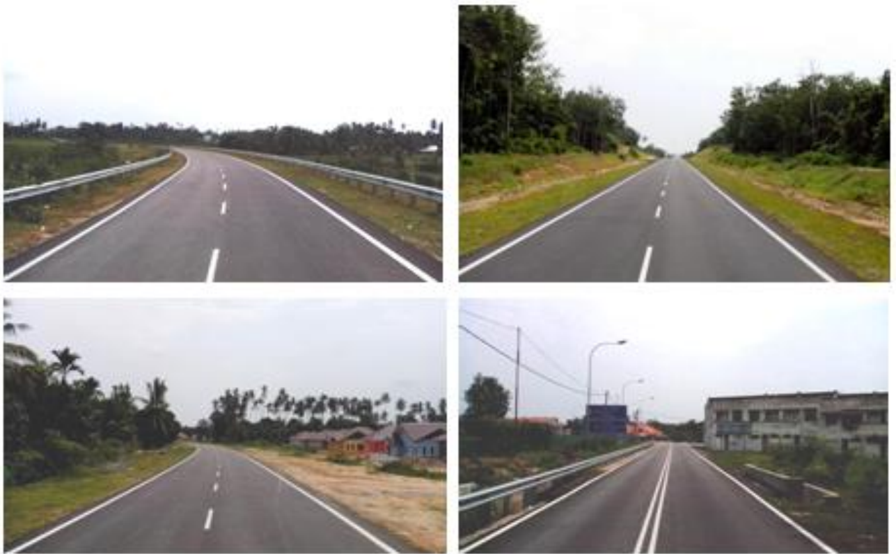
Gambar seksyen jalan yang telah disiapkan
