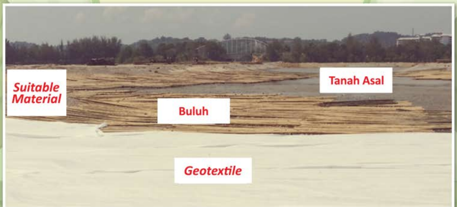
Gambar 1 : Pandangan keseluruhan pemasangan sistem geobamtile. Buluh yang telah diikat mengikut lukisan dipasang/diletakkan terus di atas tanah asal tanpa memerlukan pembuangan unsuitable material. Lapisan geotextile dihamparkan ke atas jaringan buluh bagi tujuan menghalang campuran bahan tambakan.
