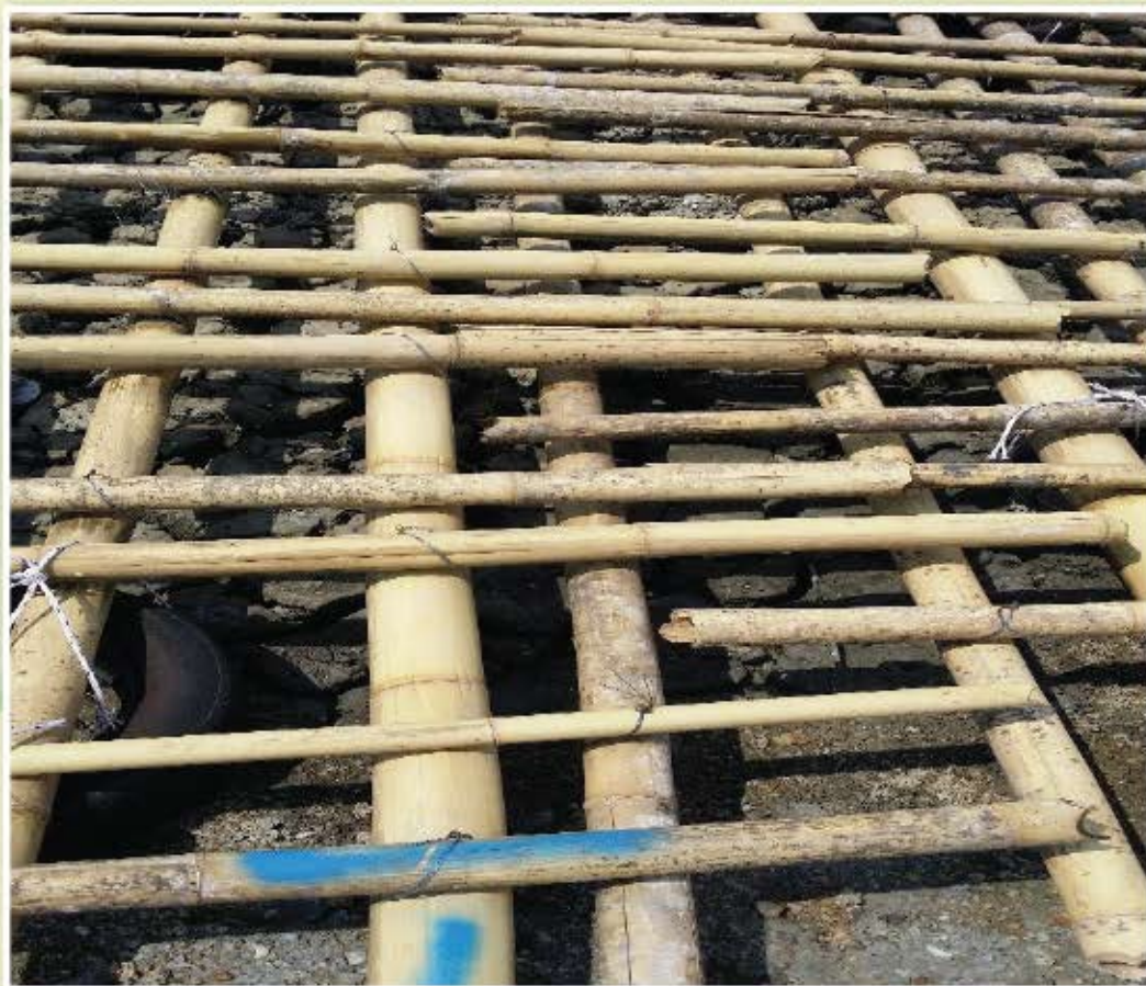
Gambar 3 : Persilangan antara buluh diikat menggunakan dawai bersalut keluli.
