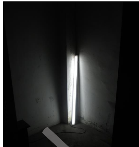
Gambar 5 – Semua lampu sedia ada tidak berfungsi di bilik LMR Blok A dan hanya temporary lighting digunakan.
