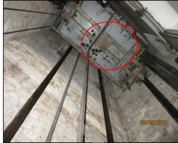
Gambar 11 – Lantai asal lif yang berlubang telah diganti dengan steel chequered plate . (L1-A)
