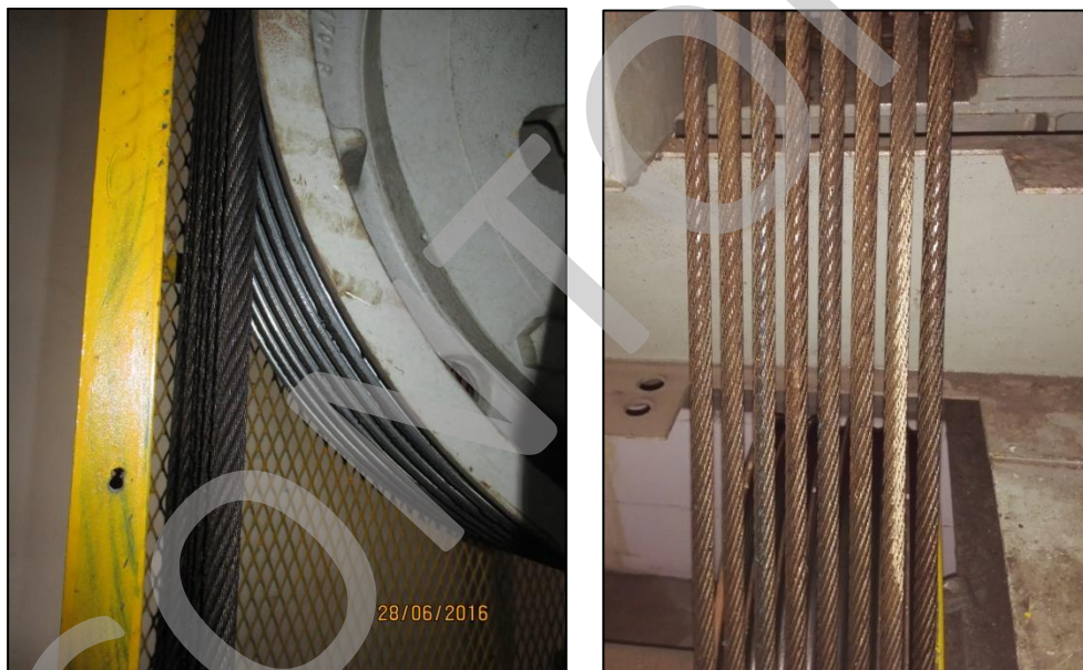
Gambar 10 – Keadaan semasa wire rope yang telah mulai berkarat.
