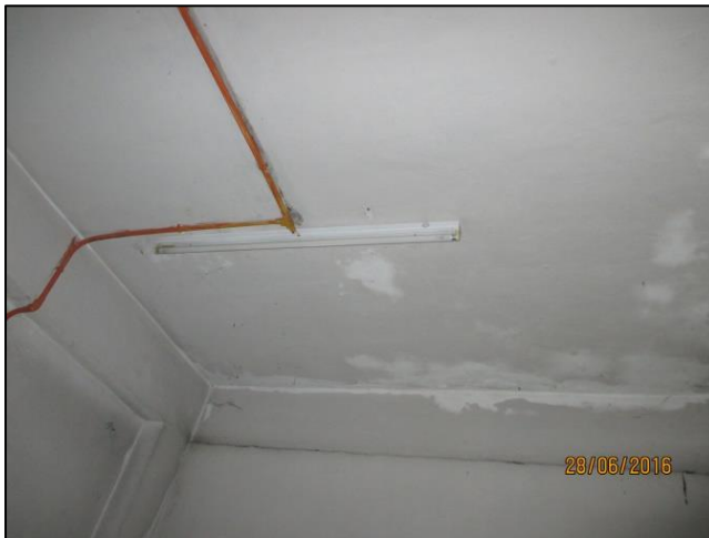
Gambar 5 – Semua lampu sedia ada tidak berfungsi di bilik LMR Blok A dan hanya temporary lighting digunakan.
