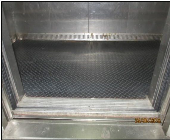
Gambar 11 – Lantai asal lif yang berlubang telah diganti dengan steel chequered plate . (L1-A)
