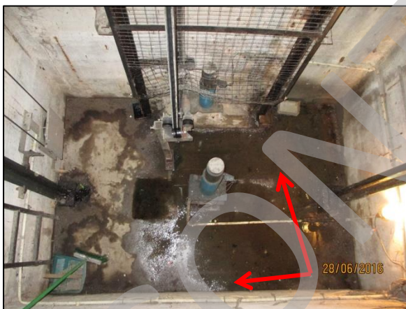
Gambar 12 – Lift pit di (L2-B) ditakungi air akibat resapan air dari luar ke dalam lift shaft di aras 7. Manakala counterweight guarding didapati telah rosak.
