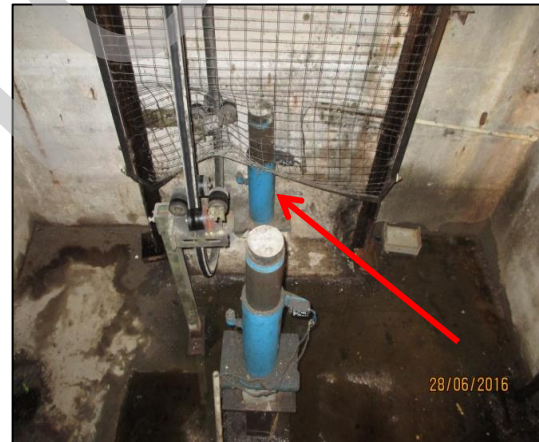
Gambar 12 – Lift pit di (L2-B) ditakungi air akibat resapan air dari luar ke dalam lift shaft di aras 7. Manakala counterweight guarding didapati telah rosak.
