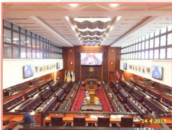
Pemasangan Sistem Mekanikal Di Dalam Dewan Negara Yang Dipadan Secara Harmoni Dengan Rekaan Dalaman Dewan
