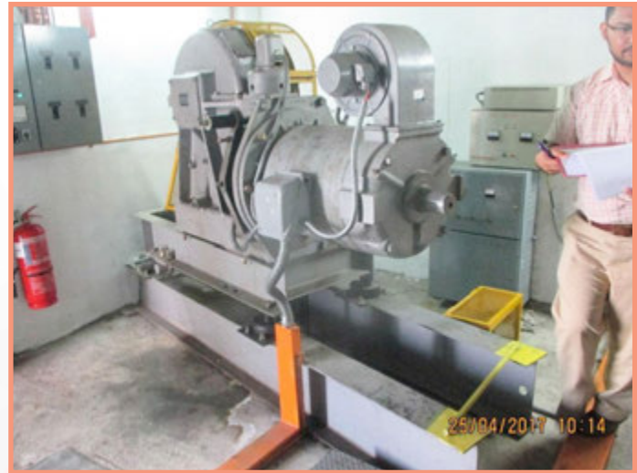
Pemeriksaan Di Dalam Lift Pit Di Rumah Persekutuan Kuala Lumpur
