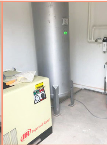
Sistem Pemampat Udara Jenis Rotary Screw Berkapasiti 53.6 CFM @ 8 Bar
