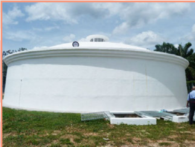
Tangki Sedutan Berkapasiti 500,000 Gallon
