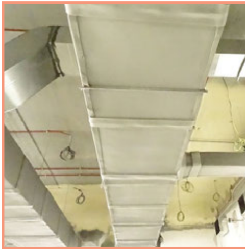
◀ Pemasangan Insulation Untuk Ducting Dengan Kemas
