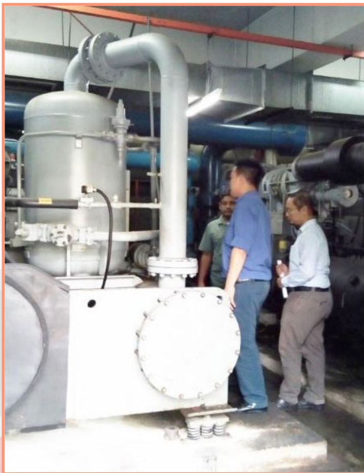
Pemeriksaan Kerosakan 3 Nos Chiller Di ASWARA Yang Berkapasiti 350 RT Setiap Satu
