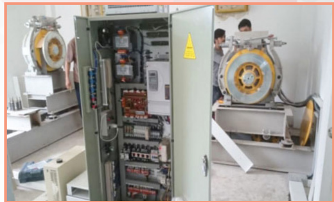
Lift Motor Dan Lift Controller System Semasa Dalam Tempoh Pemasangan Sistem Lif Di Blok Kuarters Perumahan
