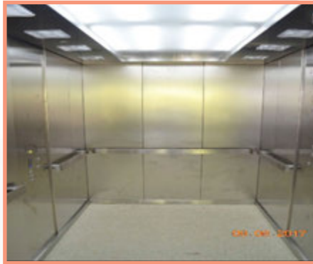
Kemasan Dalam Lif Mesra Oku Mempunyai Ciri Handrail, Voice Synthesizer Dan Braille Button
