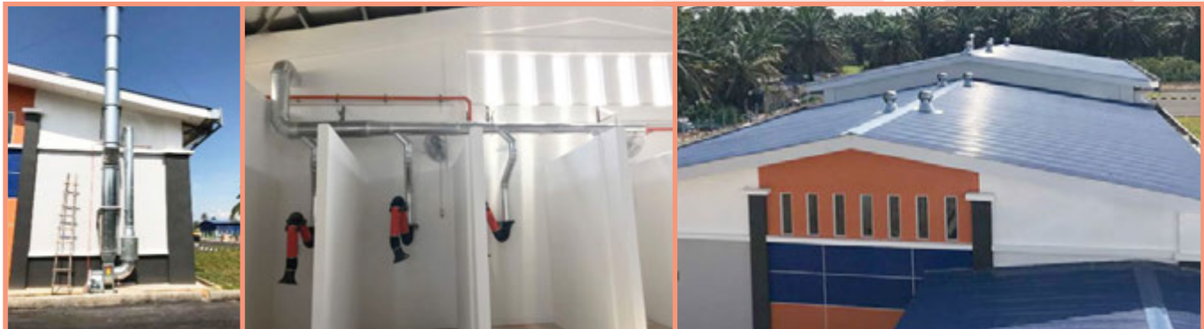
Sistem Fume Extractor Bagi Membantu Pembelajaran Praktikal Di Dalam Kursus Welding Dan Pengudaraan Di Blok Bengkel
