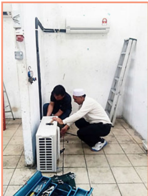
Unit Sistem Penyaman Udara Dipasang Sendiri Oleh Peserta Di ABM
