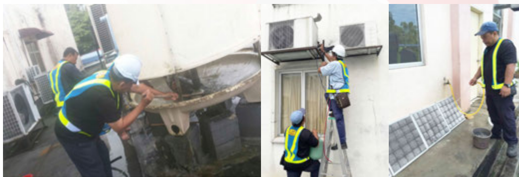
Kerja-kerja Penyelenggaraan Sistem Penyeaman Udara Oleh Staf JKR Woksyop Persekutuan
