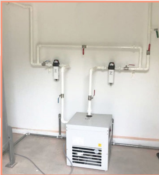
Sistem Pemampat Udara Jenis Rotary Screw Berkapasiti 53.6 CFM @ 8 Bar
