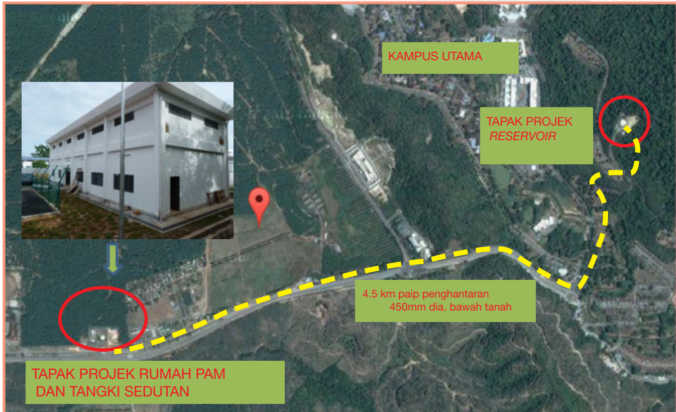
Jajaran Paip Yang Menghubungkan Tangki Sedutan, Pam Dan Tangki Reservoir
