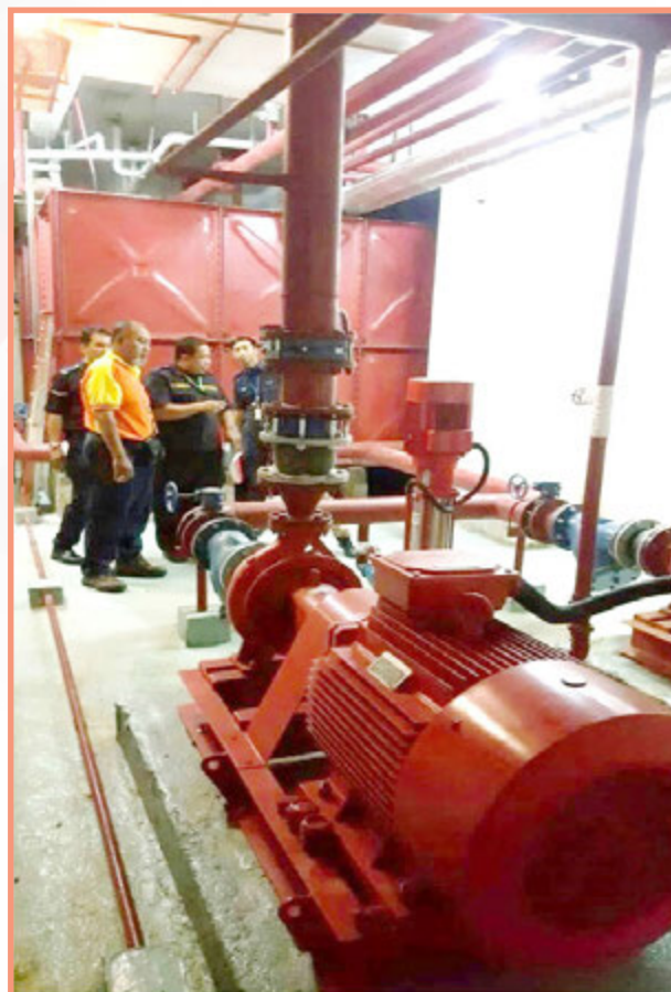
Pemeriksaan Sistem Pencegah Kebakaran Di Bangunan Suruhanjaya Koperasi Malaysia
