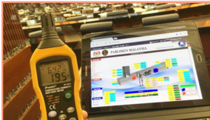
Inovasi Sistem Penyejukan Udara Dengan Penggunaan Vsd Dan Sistem Bas Bagi Memudahkan Pemantauan Dan Pengawasan Indoor Air Quality (IAQ) Melalui Tablet Atau Telefon Pintar
