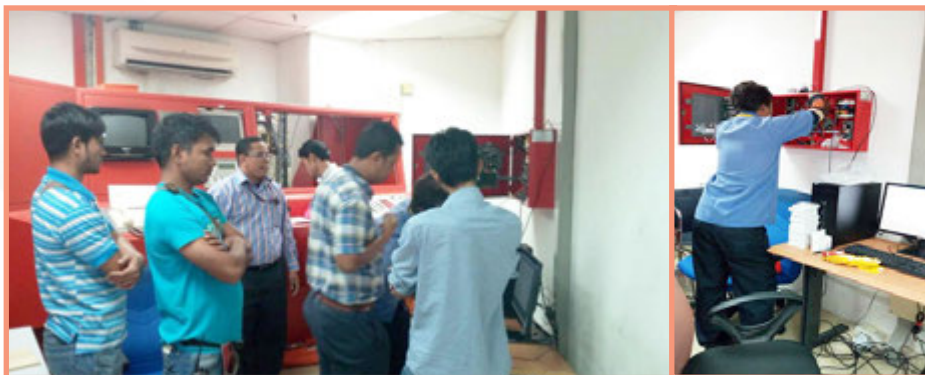
Kerja-Kerja Pemasangan Main Fire Alarm Panel Di Bilik Kawalan
