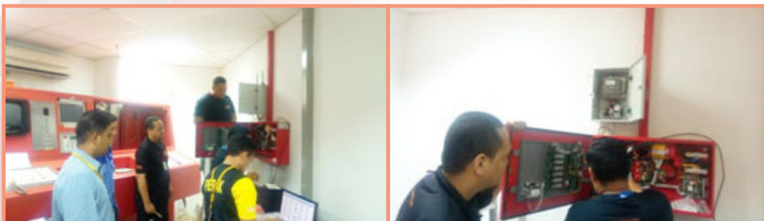
Kerja-Kerja Pemasangan Sistem Pengawasan Kebakaran Automatik (SPKA)
