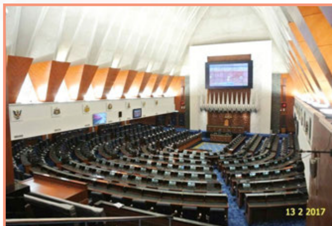
Pemasangan Sistem Mekanikal Di Dalam Dewan Rakyat Yang Dipadan Secara Harmoni Dengan Rekaan Dalaman Dewan
