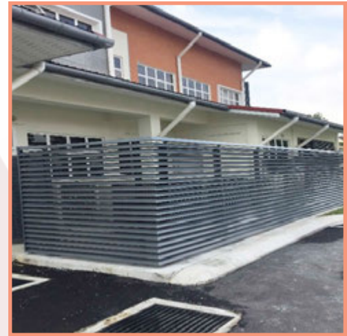
▶ Pemasangan Pagar Anti- Climb Dan Louvers Untuk Condensing Unit
