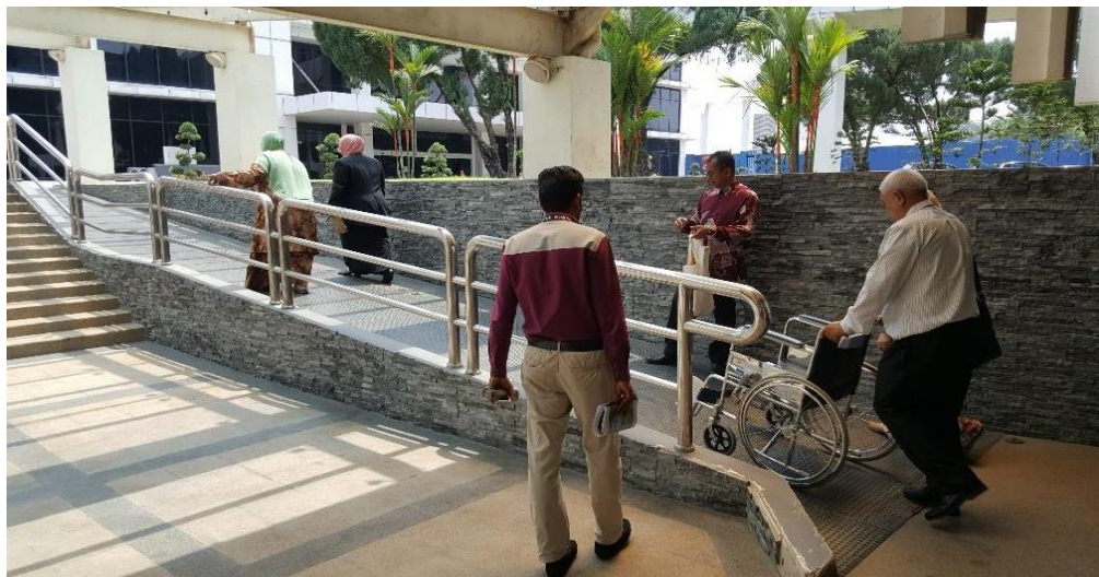
Ramp yang curam & tidak mengikut spesifikasi
