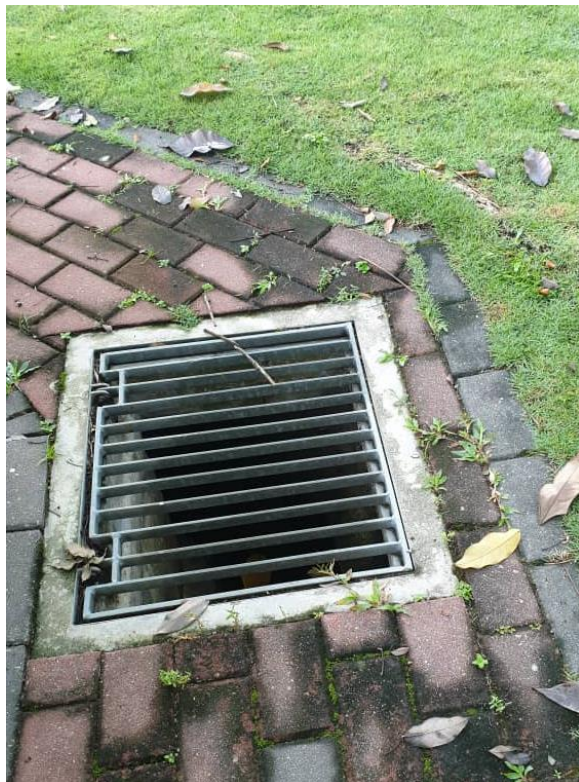
Grating yang tidak mesra OKU & kurang selamat di laluan pejalan kaki
