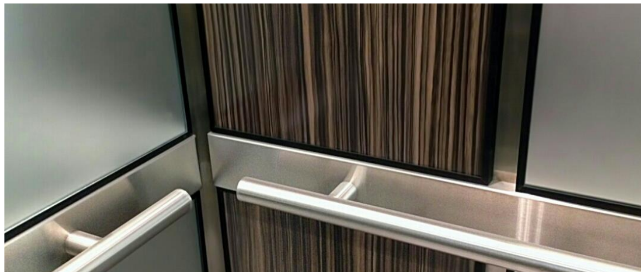
Susur tangan dan butang lif yang mesra OKU mengikut spesifikasi MS 1184
