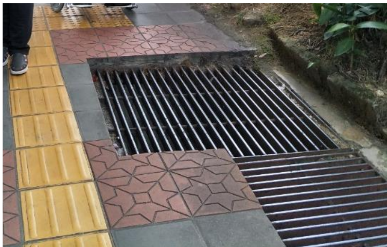
Grating yang tidak mesra OKU & kurang selamat di laluan pejalan kaki
