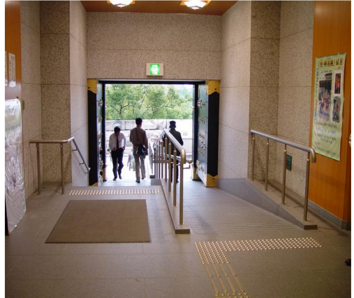
Ramp yang mengikut spesifikasi
