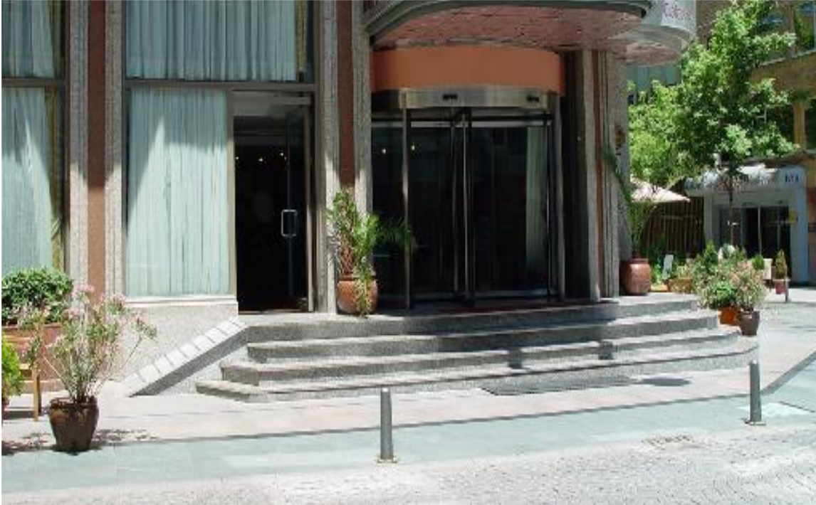
Halangan tangga pada pintu masuk bangunan
