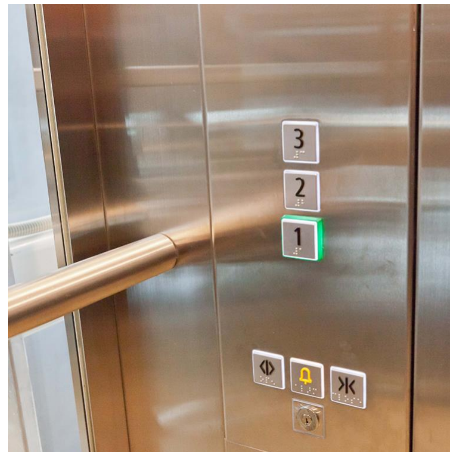
Susur tangan dan butang lif yang mesra OKU mengikut spesifikasi MS 1184
