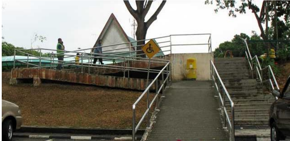
Ramp yang curam & tidak mengikut spesifikasi
