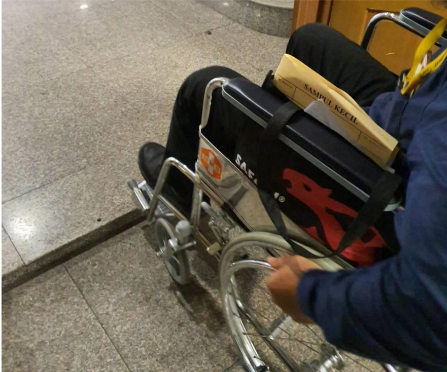
Halangan bendul pada laluan masuk bangunan
