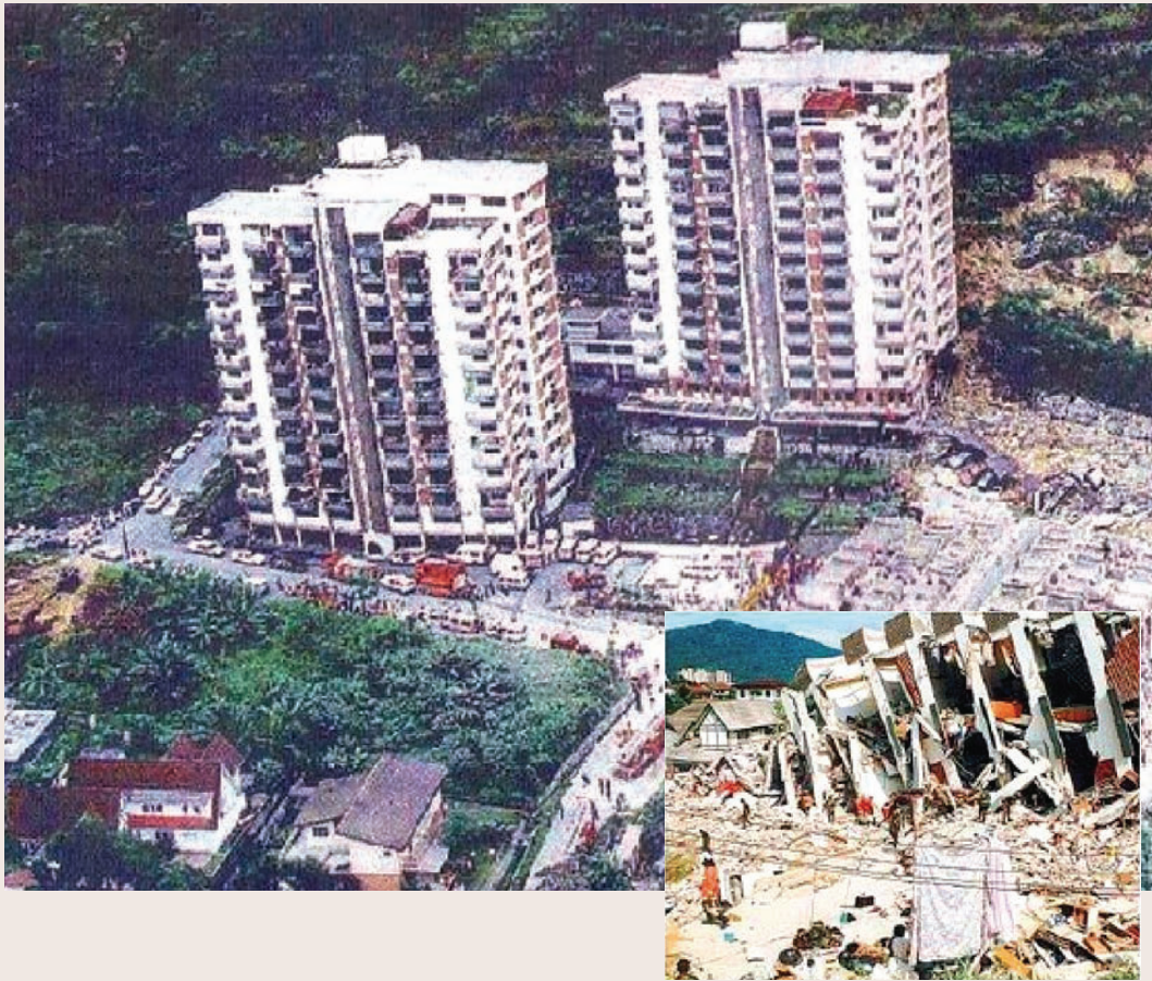
Rajah 2.3: Keruntuhan Highland Towers yang mengorbankan 48 nyawa
