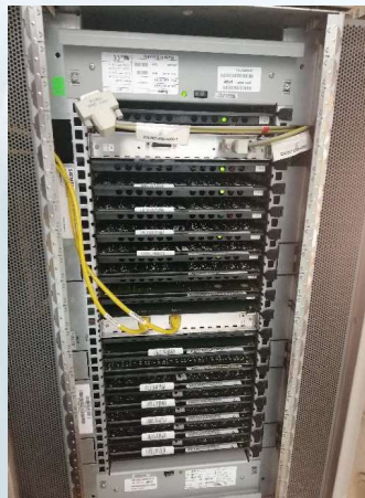
Sistem Private Automated Branch Exchange (Conventional PABX) yang dicadangkan untuk di naiktaraf kepada teknologi baru iaitu IP Private Branch Exchange (IP PBX)
