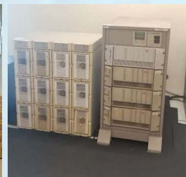
Floor Stand Uninterruptible Power Supply (UPS) dan Rectifier yang terdapat di Bangunan Sultan Iskandar, Johor yang berusia hampir 15 tahun yang mana backup time hanya selama 10 minit
