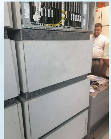
Sistem Private Automated Branch Exchange (Conventional PABX) yang dicadangkan untuk di naiktaraf kepada teknologi baru iaitu IP Private Branch Exchange (IP PBX)
