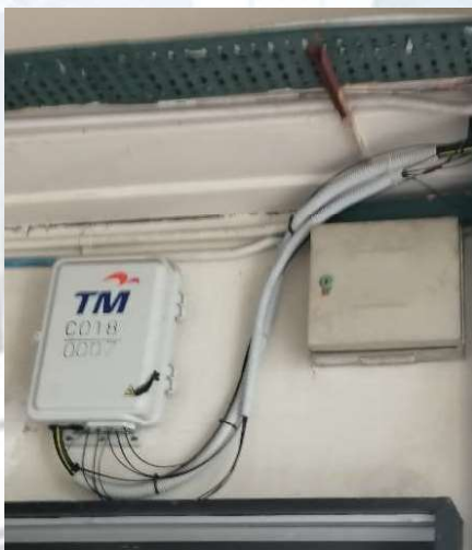
Gambar sambungan talian masuk oleh pihak pembekal dan distribution frame ke pengguna yang ditempatkan di dalam bilik yang sama
