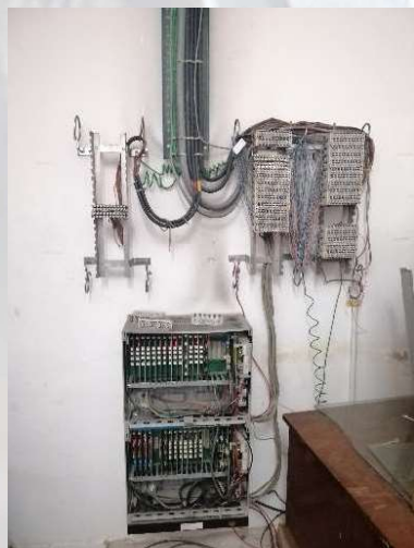
Gambar sambungan talian masuk oleh pihak pembekal dan distribution frame ke pengguna yang ditempatkan di dalam bilik yang sama
