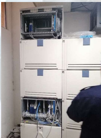
Private Automated Branch Exchange (Conventional PABX) yang dicadangkan untuk di naiktaraf kepada IP Private Branch Exchange (IP PBX)
