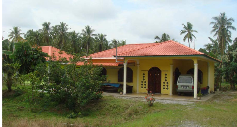
RUMAH AKAN DIROBOHKAN
