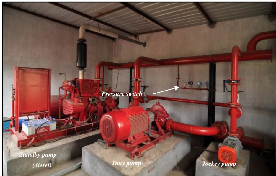
GAMBAR 1.2: CONTOH PEMASANGAN SET PAM SISTEM SPRINKLER .
