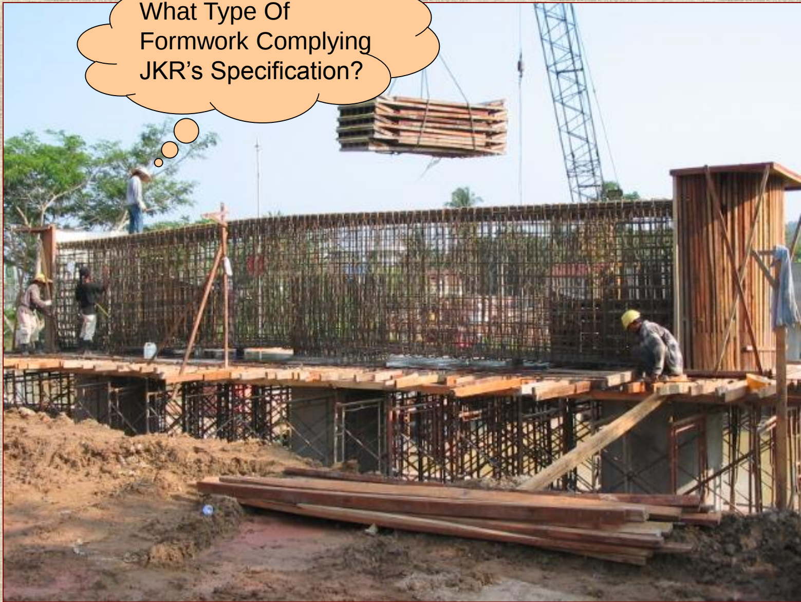
Kerja-Kerja Pemasangan Formwork Bagi Crosshead Pier
