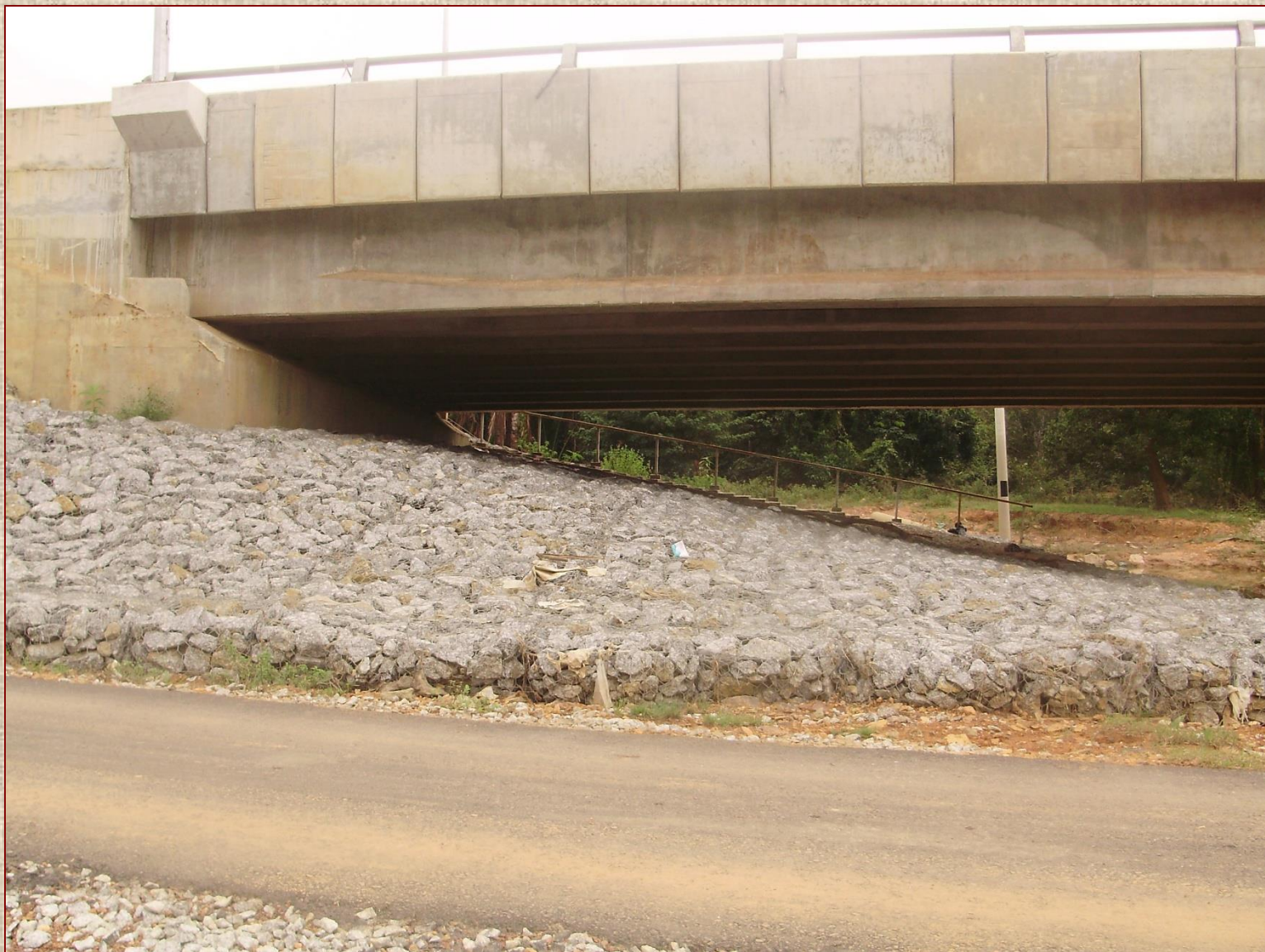
Gabion Matress Yang Siap Dipasang Di Abutment
