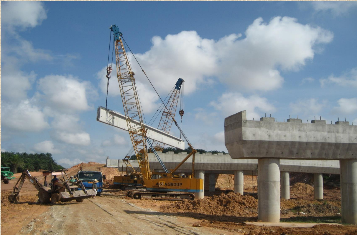
Piers Telah Siap Dibina & Menerima Pelancaran Rasuk
