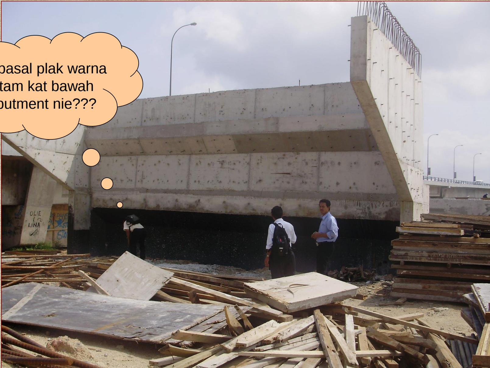
Abutment Siap Dibina
