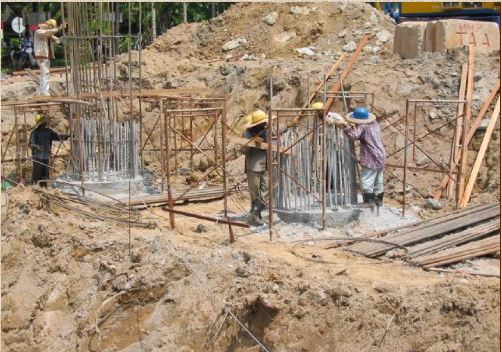
Cerucuk Bored Pile Yang Telah Siap Sehingga Cut Off Pile
