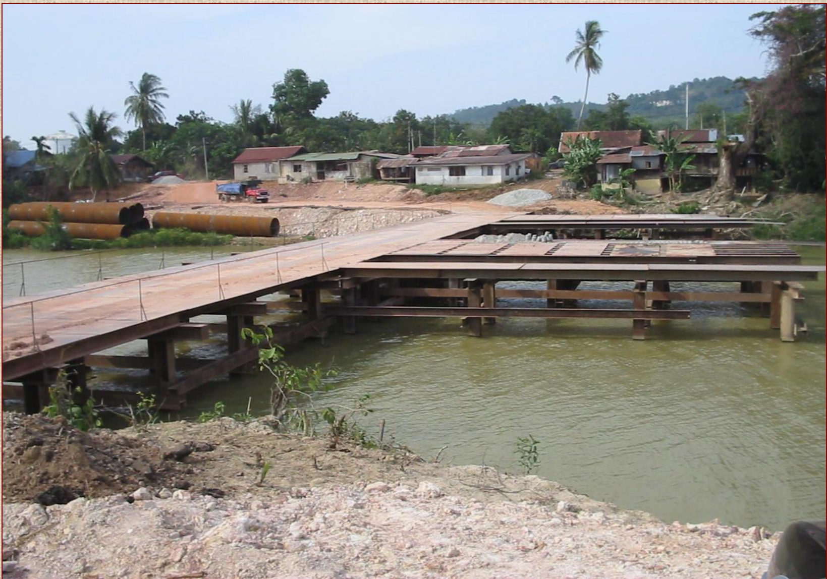
Jambatan Sementara Untuk Kerja Penanaman Cerucuk Bagi Pier
