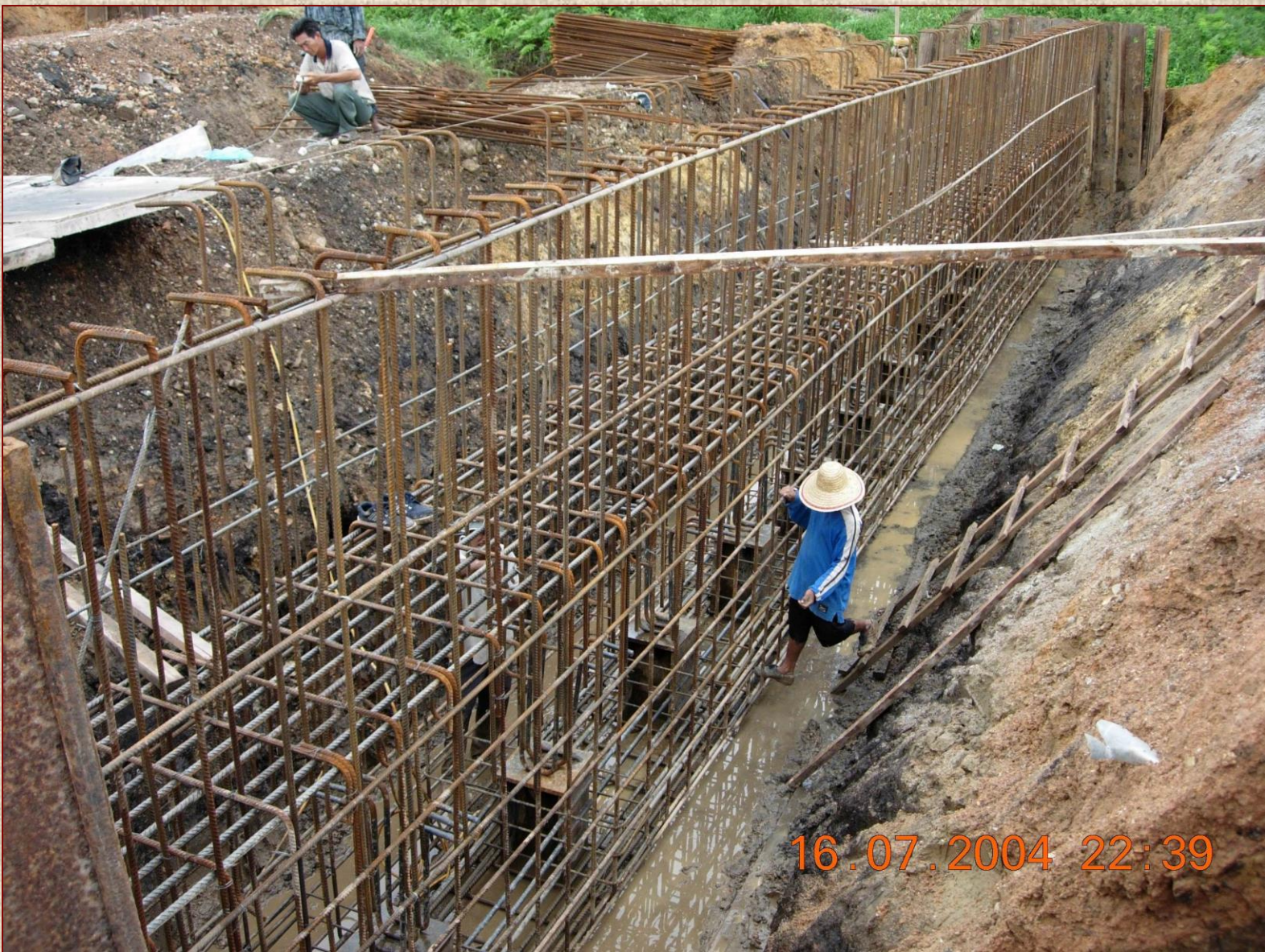
Kerja Pemasangan Besi Tetulang Sebelum Kerja Konkrit Dijalankan
