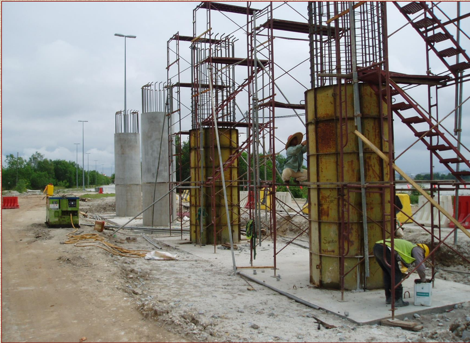
Pemasangan Formwork Siap Untuk Kerja Konkrit Pier
