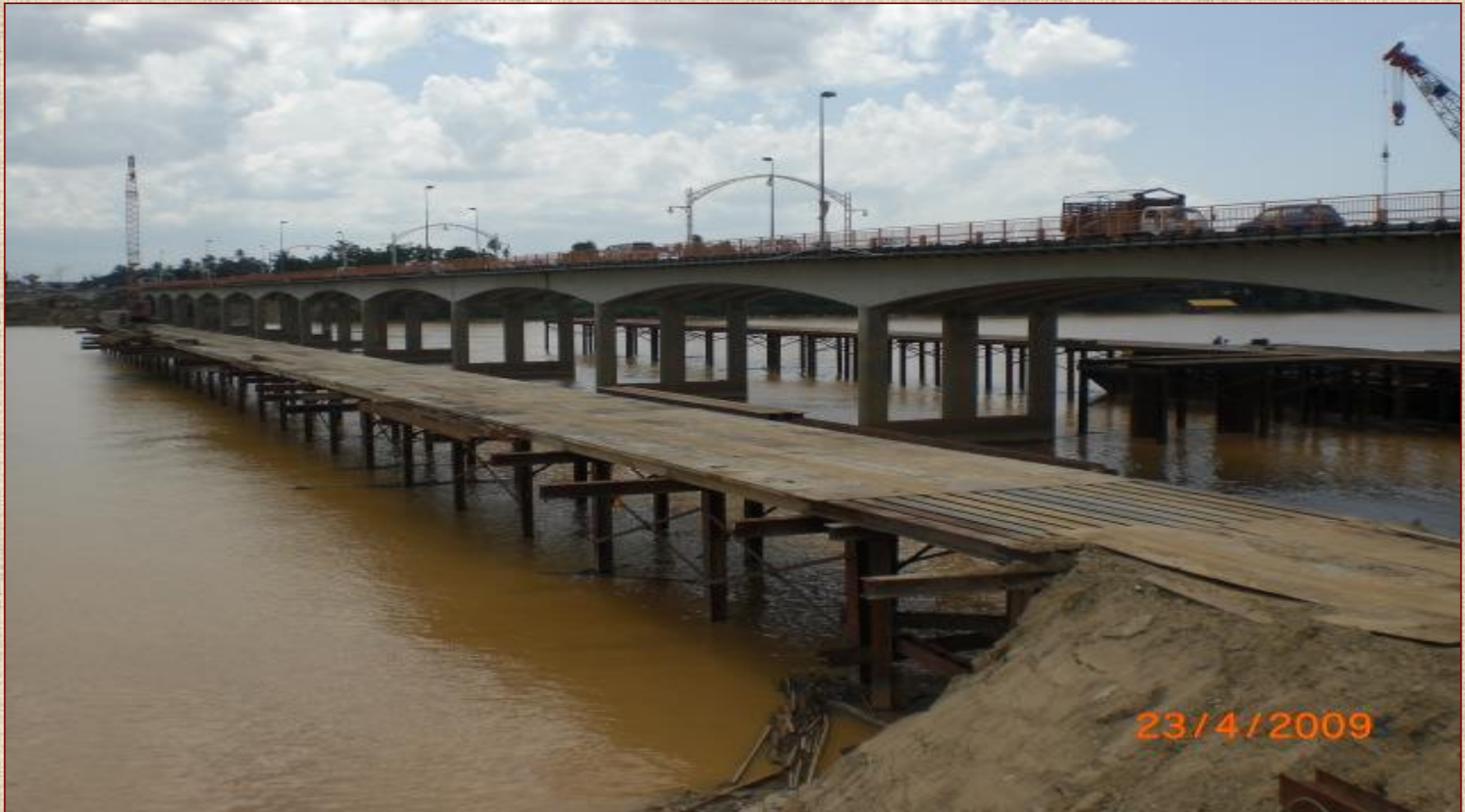
Jambatan Sementara Untuk Kerja Penanaman Cerucuk
