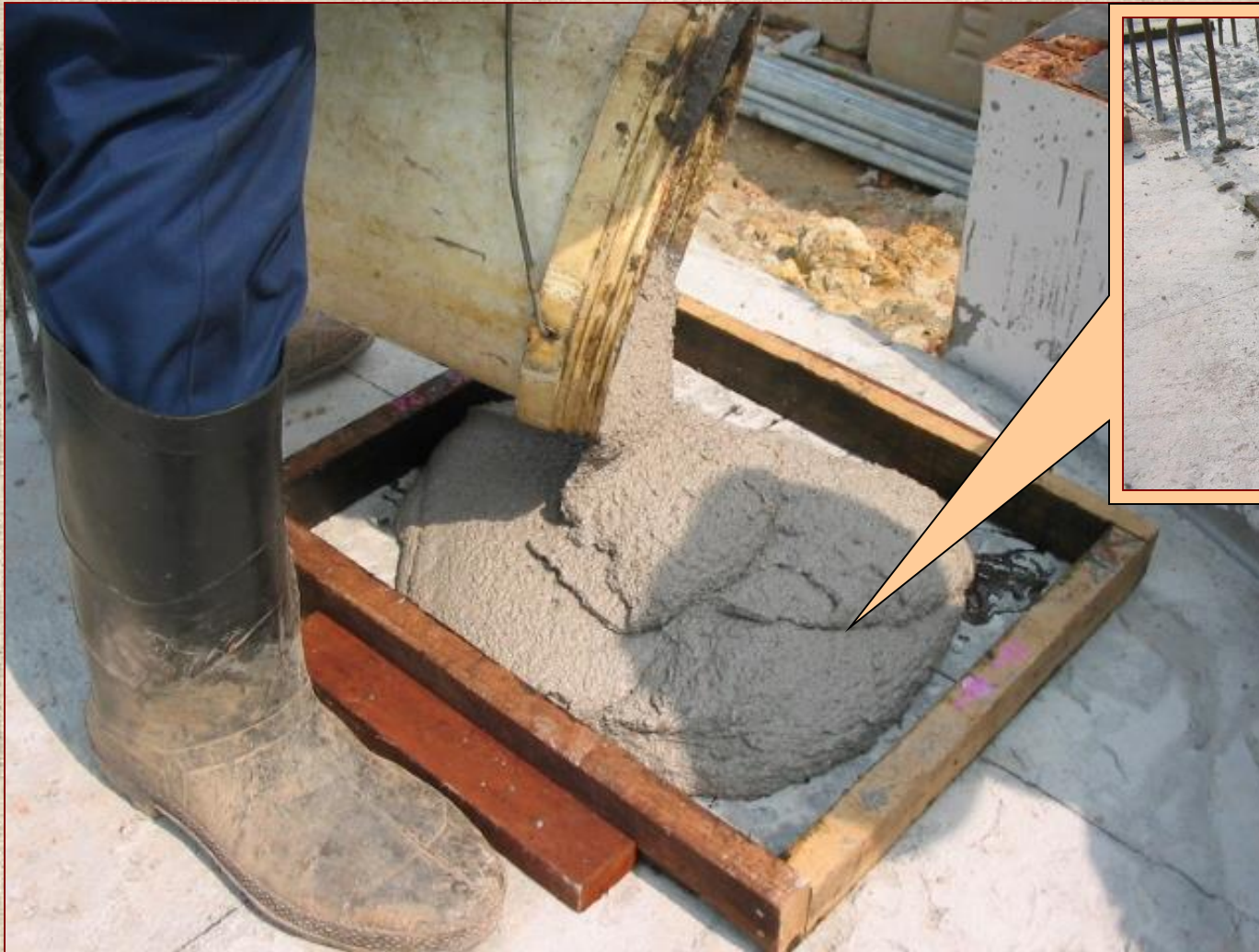
Kerja – Kerja Penyediaan Rubber Bearing Setting – Plinth Concrete
