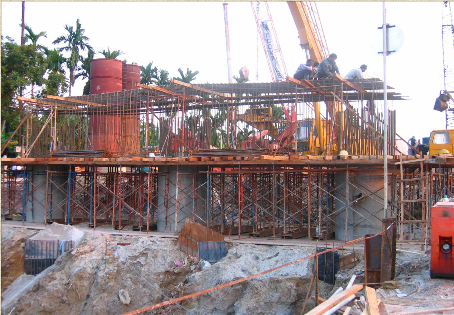
Kerja–Kerja Pemasangan Besi Tetulang Bagi Crosshead Pier
