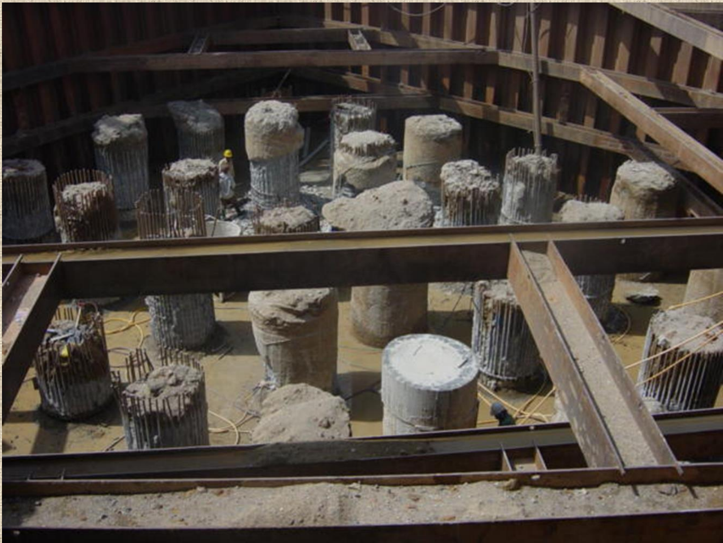
Kerja-kerja Cut off pile dalam Coffer Dam
