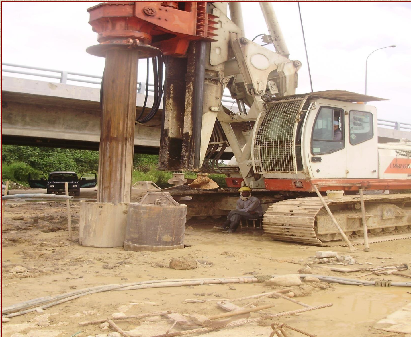
Kerja Penggerudian Bored Pile Sedang Dijalankan
