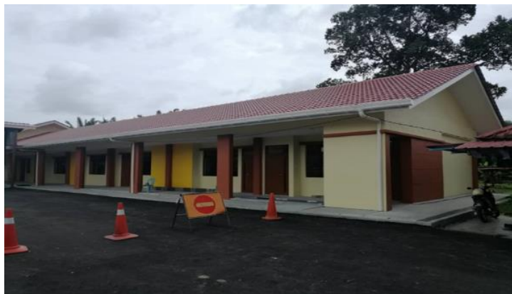
Sekolah Daif 2019 : Kerja Meroboh Dan Membina Bangunan 6 Bilik Darjah, 3 Bilik PPKI, Tandas dan Lain-Lain Kemudahan SK Seri Paya BATU PAHAT, JOHOR
