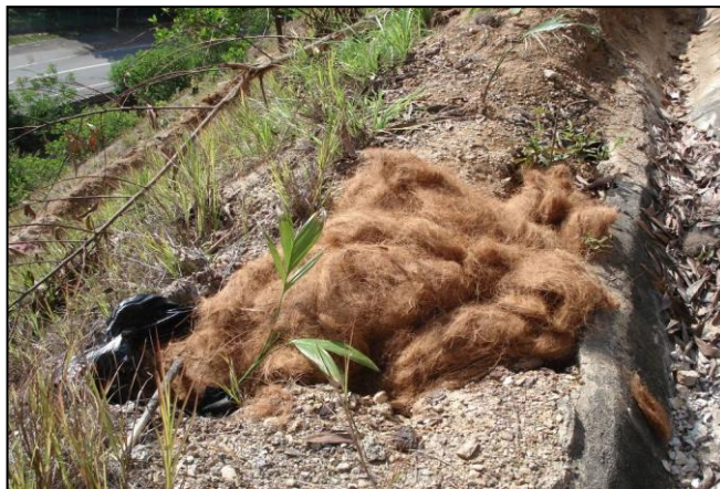
Gambar 4.2(c): Penggunaan bahan secara pengisian sabut kelapa.
