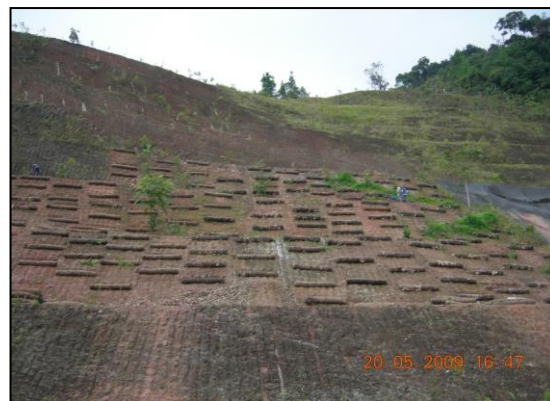
Gambar 4.1: Susun atur 'coil-roll' bersama spesies tanaman secara berlandskap.
