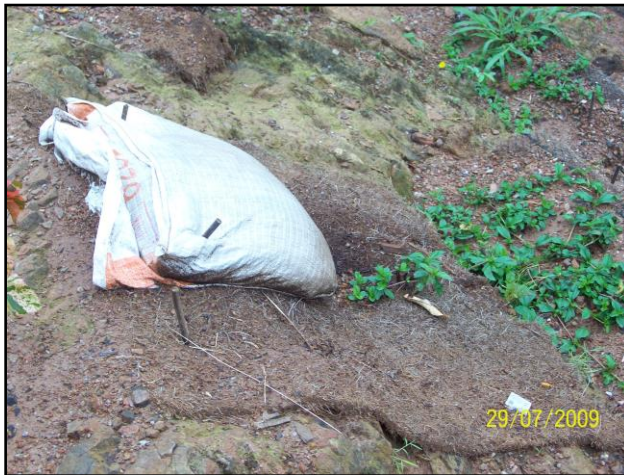
Gambar 6.1 (d) : Beg baja diletakkan pada cerun.
