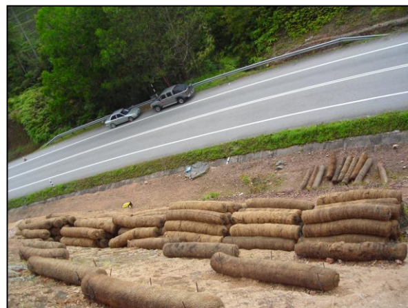
Gambar 4.2(a): Penggunaan struktur penahan jenis 'coil roll'
