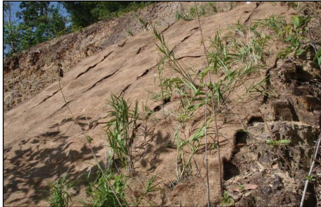
Gambar 4.2(b): Penggunaan secara hamparan 'fibre-mat' jenis sabut kelapa.
