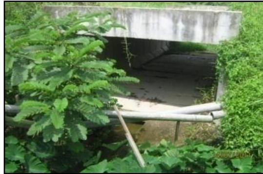
Aras Culvert Dibina Atas Aras Air
