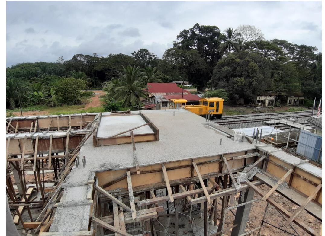
SUNKEN FLOOR DI LANTAI TANGKI AIR
