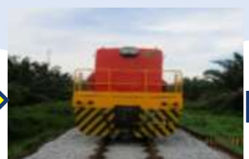
Landasan yang siap dinaik taraf diuji (roll-over) untuk kebolehfungsian
