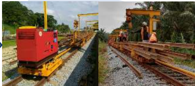
Rel kimpal berpanjangan 144meter UIC54kg dihantar ke tapak dan disusun di tepi landasan menggunakan 'rail train'
