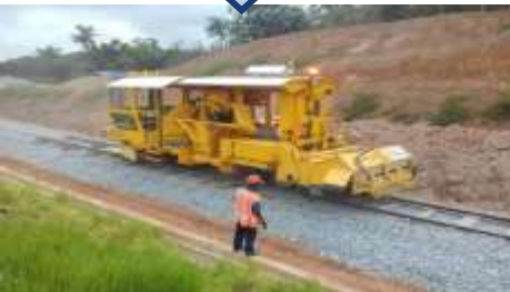
Batu balas diratakan dan dibentuk menggunakan mesin 'ballast regulator'
