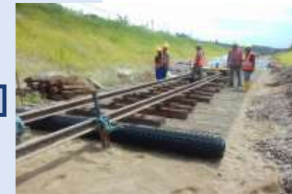
100mm pasir dan 'geogrid' dihamparkan di atas 'geotextile'
