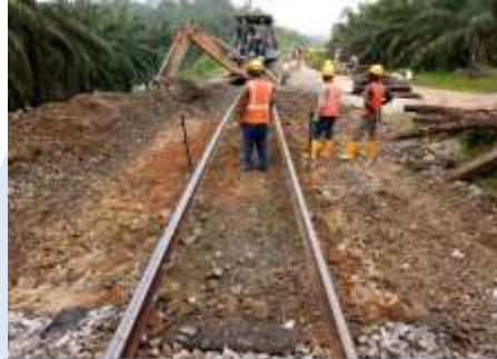
Pengalas kayu sedia ada ditanggalkan dan batu balas bercampur lumpur dikorek ke sub-balas
