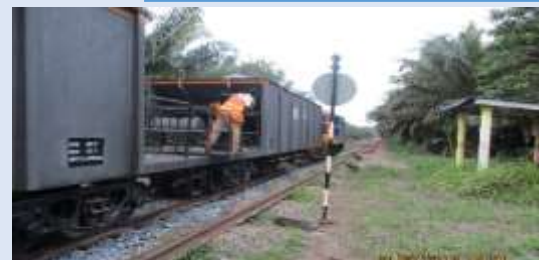
Batu balas baru dihamparkan di atas panel 18meter menggunakan mesin 'ballast wagon'
