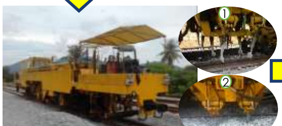
Batu balas dipadatkan menggunakan mesin 'tamping'
