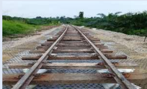
Pengalas kayu dipasang semula dan guni diisi batu balas diletakkan di bawah pengalas sebagai sokongan
