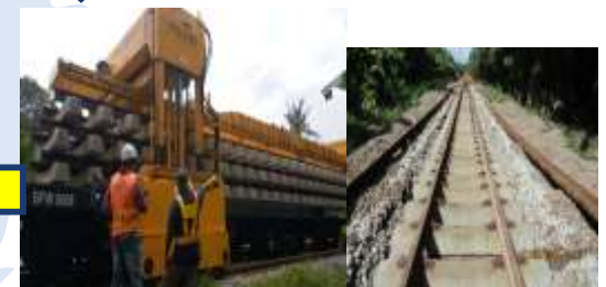
Rel & pengalas konkrit (panel 18meter) disusun di atas sub-balas / aras formasi menggunakan mesin PTH
