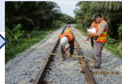
Bacaan landasan diambil menggunakan 'track gauge'
