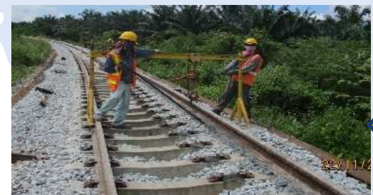
Rel panel 18meter ditukar dengan rel kimpal berpanjangan 144meter UIC54kg
