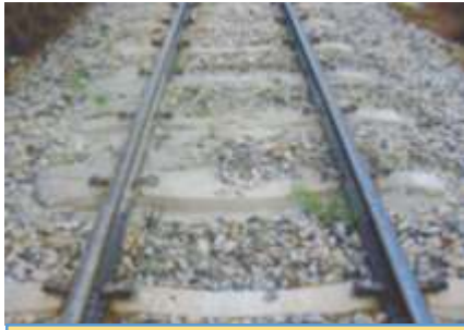
Keadaan tipikal batu balas sedia ada yang telah bercampur dengan lumpur (mud pumping)
