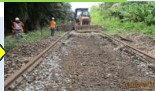
Rel dan pengalas kayu sedia ada dibongkar sebelum batu balas lama dikorek ke sub-balas
