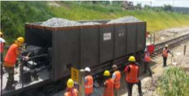
Batu balas baru dihamparkan di atas 'geogrid' menggunakan mesin 'ballast wagon'
