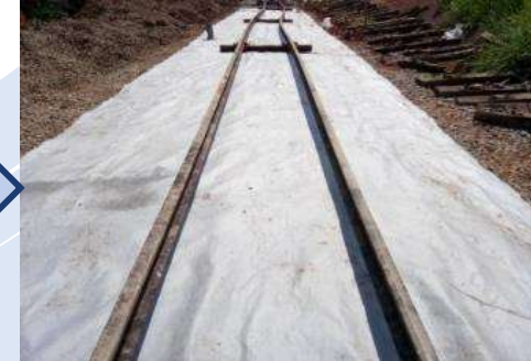
'Geotextile' dihamparkan di atas sub-balas yang telah dipadatkan
