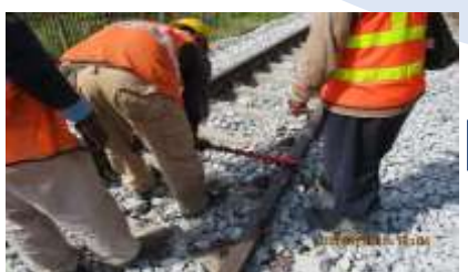
Bacaan landasan diambil menggunakan 'track gauge'
