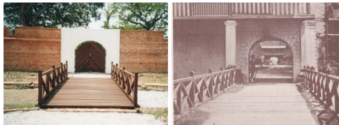
Gambar 2.5: Pembinaan tembok baharu bahagian barat Kota Cornwallis (gambar kiri) adalah merujuk kepada foto lama (gambar kanan).
