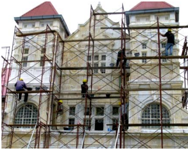
Pemuliharaan Bangunan Muzium Taiping, 2008
