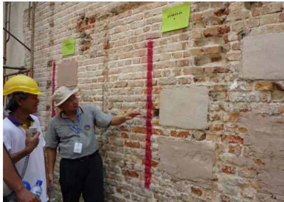
Gambar 4.2: Membuat ujian lepaan ke atas beberapa sampel mortar.
