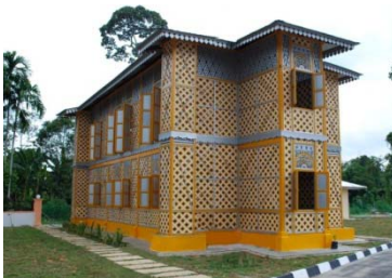
Masjid Lama Kampung Kuala Dal, Kuala Kangsar, Perak. Bangunan kelarai buluh (1938), dipulihara semula pada 2009 dengan mengekalkan seni bina, bahan dan kaedah binaan yang asal.
