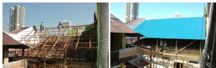
Gambar 2.3: Pembinaan bumbung sementara bagi melindungi struktur bumbung asal dan bangunan.
