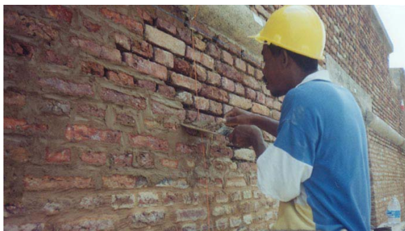
Gambar 4.3: Kerja memasuk dan menyambung mortar ( repointing mortar ) yang dilakukan dengan baik akan dapat menonjolkan karektor sejarah bangunan.
