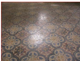
Jubin lantai lama bercorak yang masih baik di Rumah Teh Bunga, Jalan Huttin, Pulau Pinang
