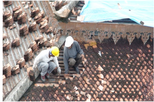
Gambar 4.1: Mengeluar dan mengumpul genting senggora lama
