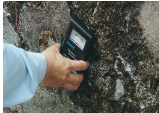
Gambar 3.2: Mencerap bacaan kelembapan menggunakan Moisture Meter
