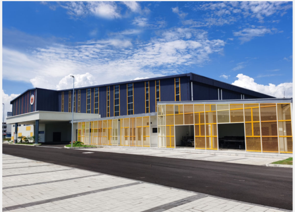
DEWAN SUKAN SERBAGUNA DAN KAFETERIA
