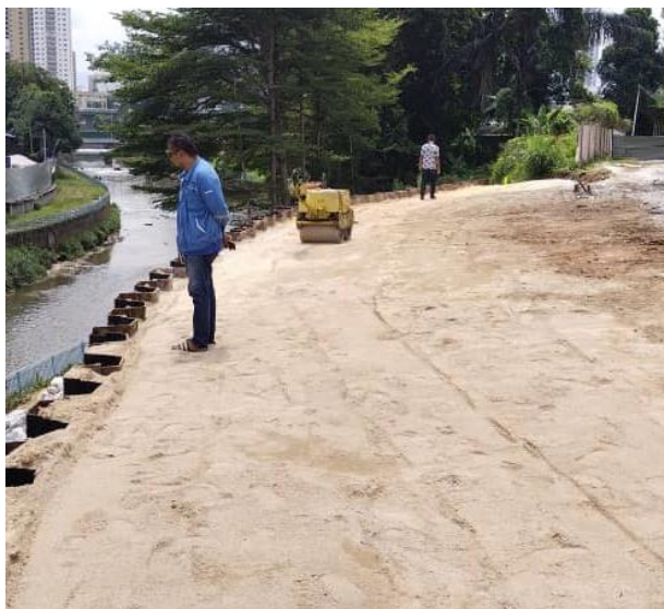
Kerja Backfilling Di Dalam Sheet Pile
