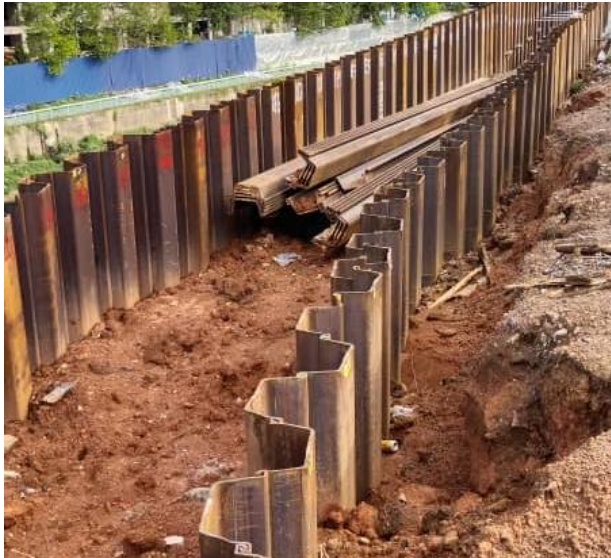
Sheet Pile Yang Siap Ditanam
