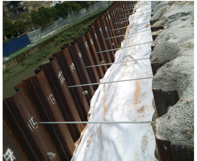
Sheet Pile Yang Telah Dipasang Tie
