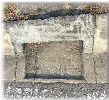
Kerb opening inlet yang dibina di tapak.
