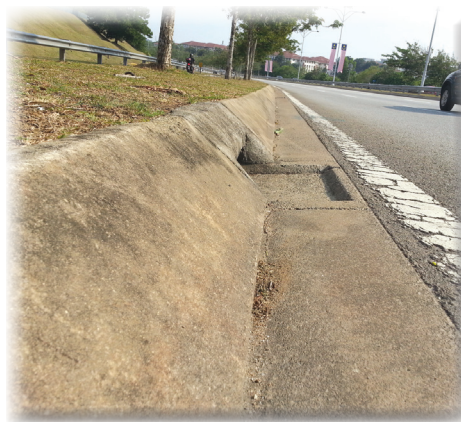
Kerb opening inlet yang dibina di tapak.
