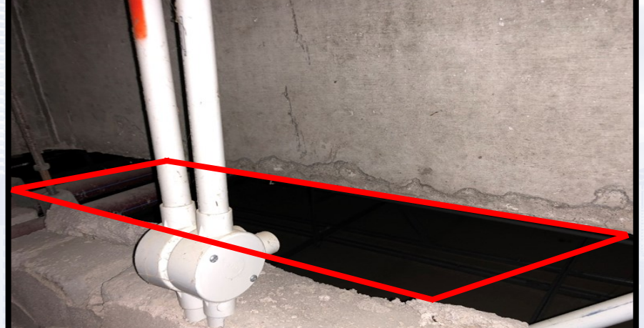
Bukaan yang membenarkan infiltrasi udara luar
