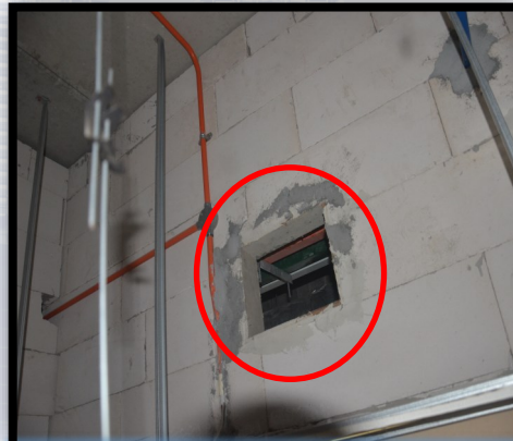
Bukaan di dalam siling mengakibatkan infiltrasi udara luar ke dalam bilik
