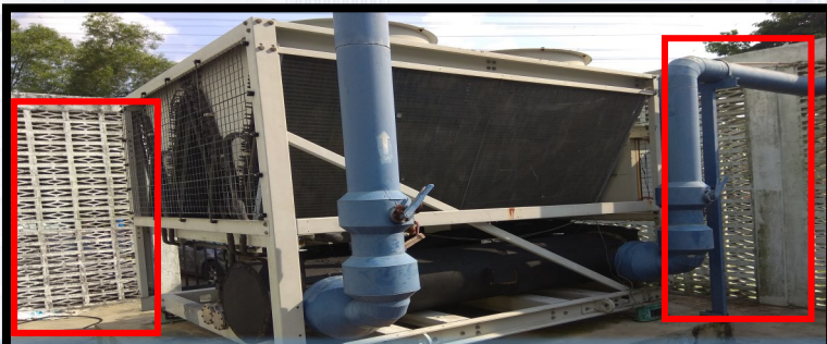
Loji mekanikal yang dibina tanpa penamparan bunyi
