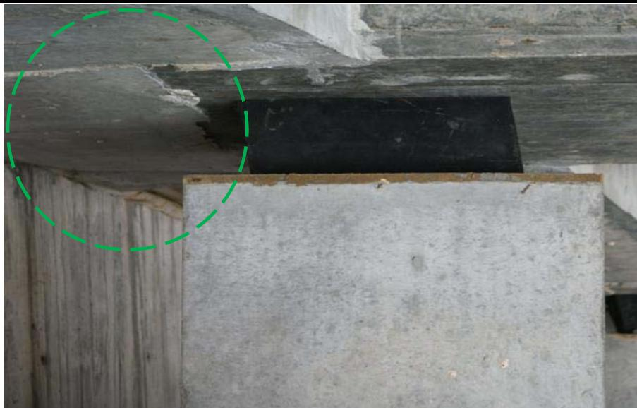
Struktur abutmen tidak mengalami sebarang pecahan / peluruhan konkrit (spalling) di bahagian yang dibulatkan pada gambar
