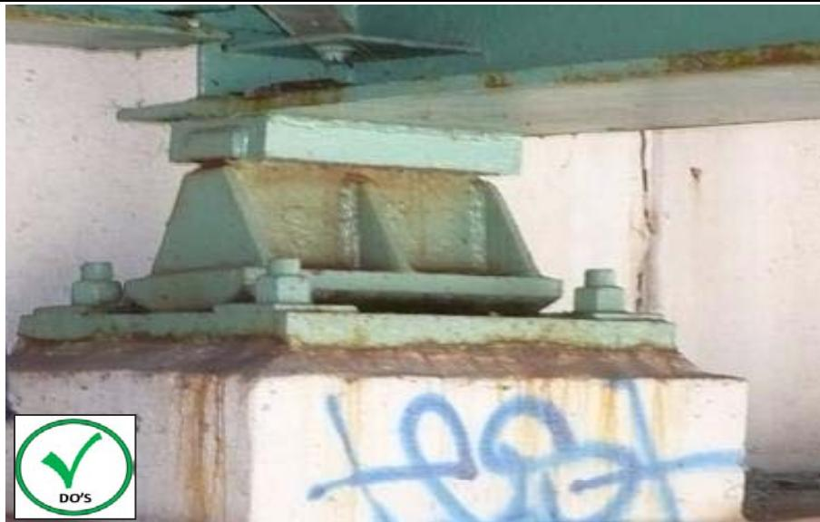
"Rocker bearing" perlu dipastikan berada di dalam keadaan normal iaitu di atas plint tanpa sebarang perubahan posisi yang ketara
