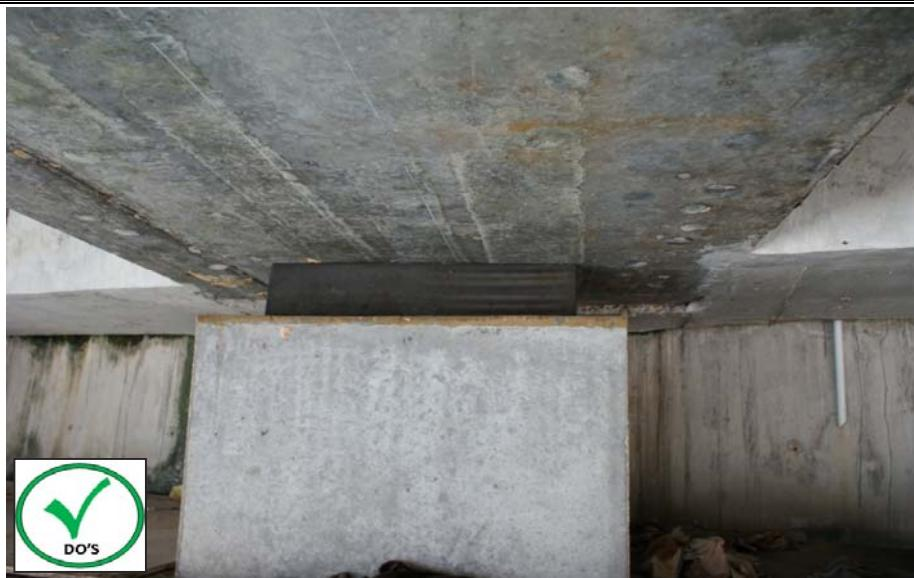
Pastikan bentuk bearing kekal seperti asal dengan toleran pencacatan bentuk (deformation) adalah dalam had yang dibenarkan sebagaimana spesifikasi pembekal
