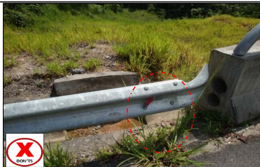
Panjang julur guardrail tanpa dipasang tiang (post). Amalan rekabentuk yang biasa adalah 1.5 meter untuk panjang julur (cantilevered). Rujuk Arahan Teknik Jalan 1/85.
