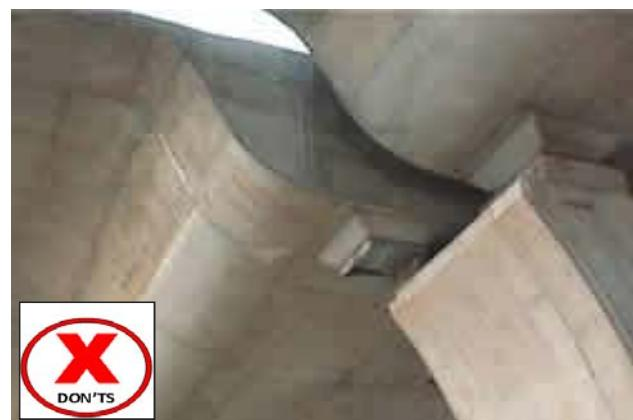
Pergerakan atau anjakan (displacement) yang berlebihan pada struktur pier menyebabkan lokasi bearing turut mengalami anjakan yang ketara
