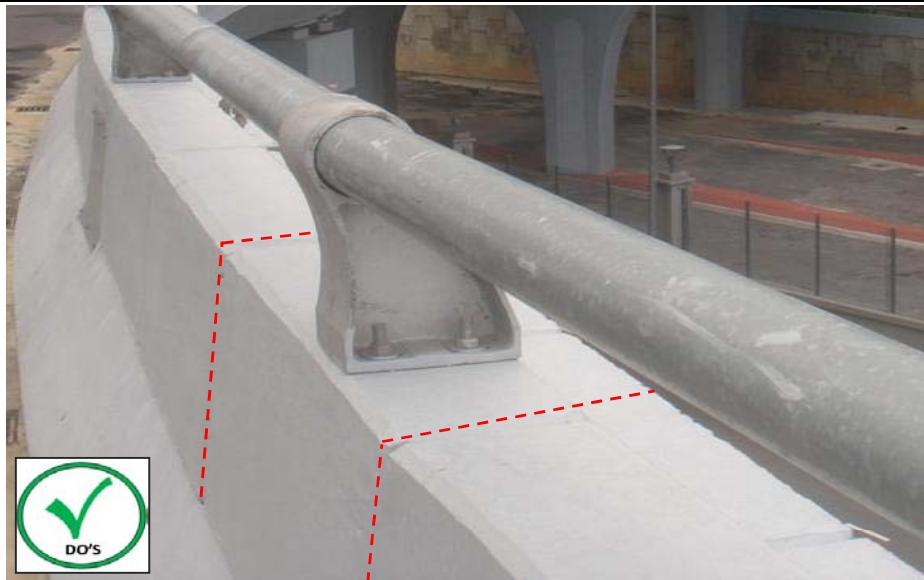
Amalan terbaik bagi pemasangan railing parapet adalah di tengah-tengah komponen individu parapet bagi memberikan kekuatan pada tambatan bolt dan mengelakkan keretakan pada parapet
