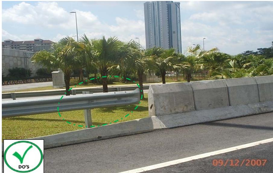
Tiang (post) bagi guardrail dipasang pada jarak kurang dari 1.5 meter untuk panjang julur guardrail.
