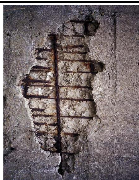
Struktur abutmen mengalami pecahan (spalling) yang teruk sehingga menampakkan keluli tetulang yang berkarat disebabkan oleh kualiti pembinaan yang teruk seperti saiz penutup konkrit tidak mengikut rekabentuk ( +10mm mengikut ukuran ditapak )
