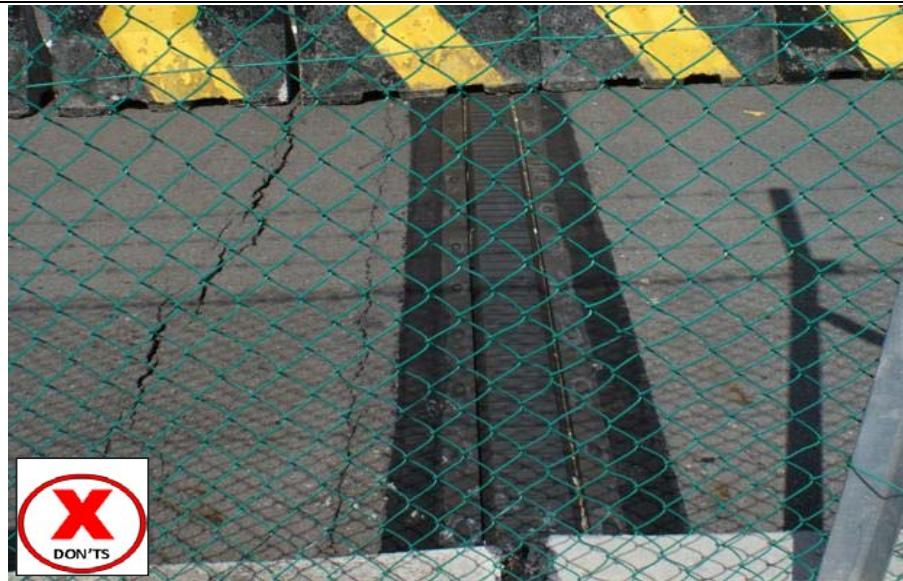
Terdapat keretakan yang teruk pada turapan berhampiran "expansion joint" yang disebabkan oleh kerosakan teruk pada struktur abutmen ataupun berlaku pemendapan tanah di bawah turapan
