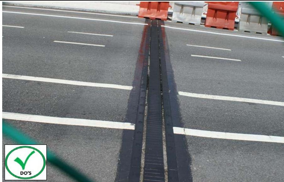
Tiada sebarang keretakan dikesan pada turapan berhampiran "expansion joint" menunjukkan tidak masalah atau kerosakan yang teruk pada struktur abutmen
