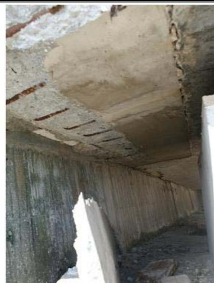
Struktur abutmen mengalami pecahan / peluruhan konkrit (spalling) yang teruk pada lokasi struktur abutmen yang sama iaitu di belakang bearing.
