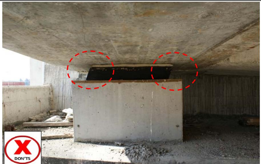
Pencacatan rincih yang melebihi had yang dibenarkan ke atas bearing getah yang disebabkan oleh rekabentuk / pembinaan yang lemah atau bearing yang kurang berkualiti atau tidak memenuhi spesifikasi
