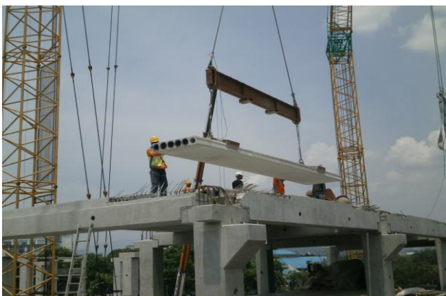
Gambar 2: Pemasangan Komponen IBS
