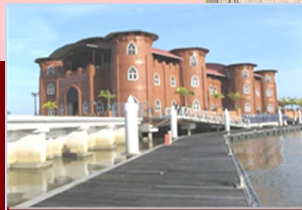
Marina Kuala Kedah, Kedah - Kos RM37.28 Juta. Siap Pada 15.08.2003 Dan Dibaiki Pada 07.05.2008 Tetapi Belum Beroperasi
