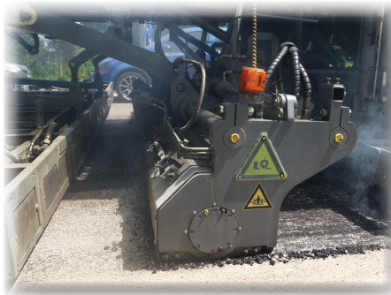
Pemecahan asphalt sedia ada.
