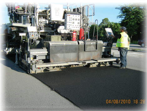
Penurapan semula asphalt.
