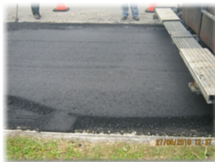
Bahan recycle yang tidak mencukupi semasa penurapan.
