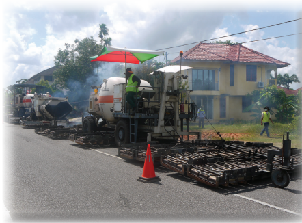
Pemanasan permukaan jalan sedia ada.
