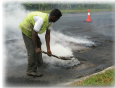
Membuang bitumen hangus.
