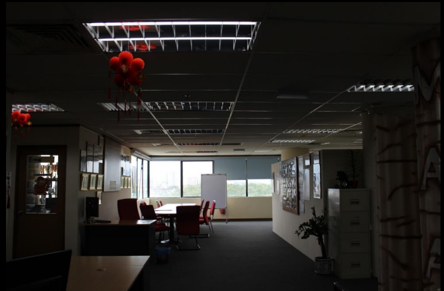
KEROSAKAN LAMPU KECEMASAN
