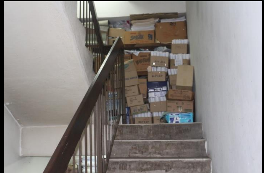
Halangan pada tangga keselamatan
