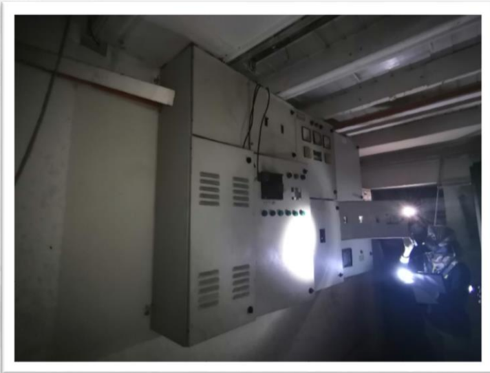
PEMERIKSAAN KEADAAN SEMASA PERALATAN DAN PEPASANGAN ELEKTRIK DI BANGUNAN KTMB
