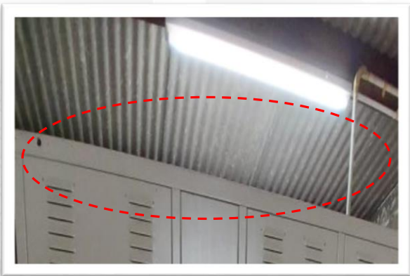
Tiada lampu kecemasan disediakan di dalam bilik MSB
