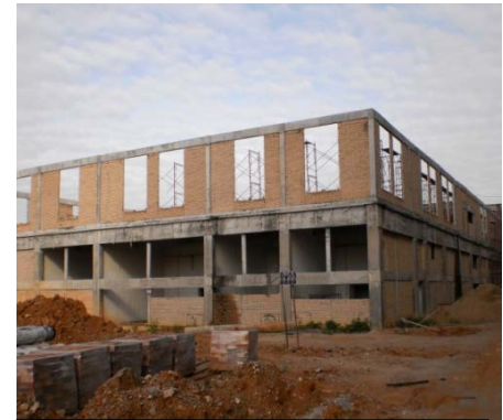
BLOK MEKANIKAL & ELEKTRIKAL
