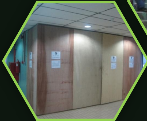
PEMASANGAN SAFETY BARRICADE
