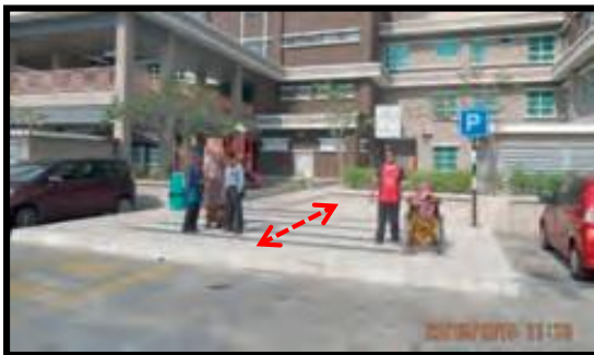
Kawasan parkir awam - tiada ramp di kawasan parkir bagi kemudahan pesakit/pelawat oku
