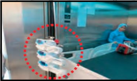
Saiz/ruang lif yang tidak sesuai
