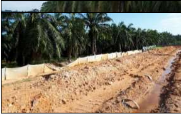
Rajah 2 : Langkah Pembaikan slope pada gradient (1:4)
