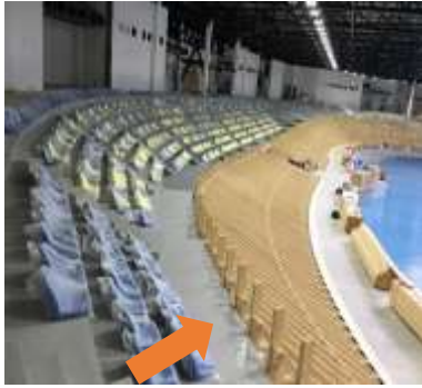
Pemasangan timber surface
