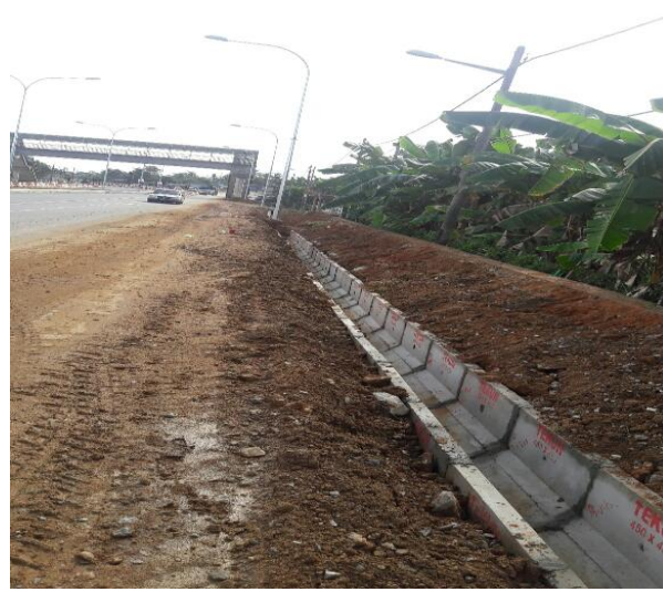
Kerja-kerja Pemasangan Lampu Jalan
