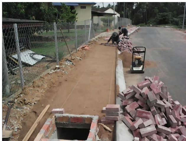
Kerja-kerja Pemasangan Paving Block
