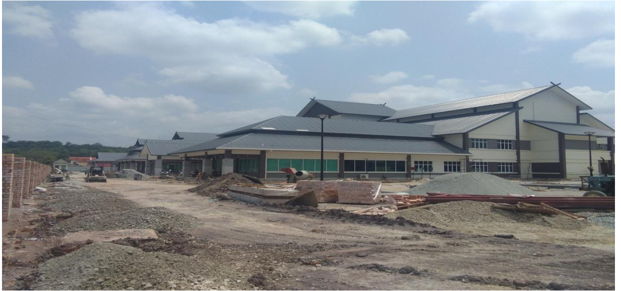
4.7 Pembinaan bangunan blok bangunan pejabat
