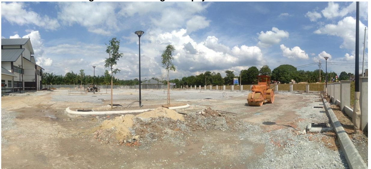
4.8 Pembinaan tempat letak kenderaan
