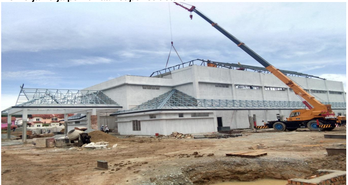
4.6 Pembinaan Blok Dewan Serbaguna
