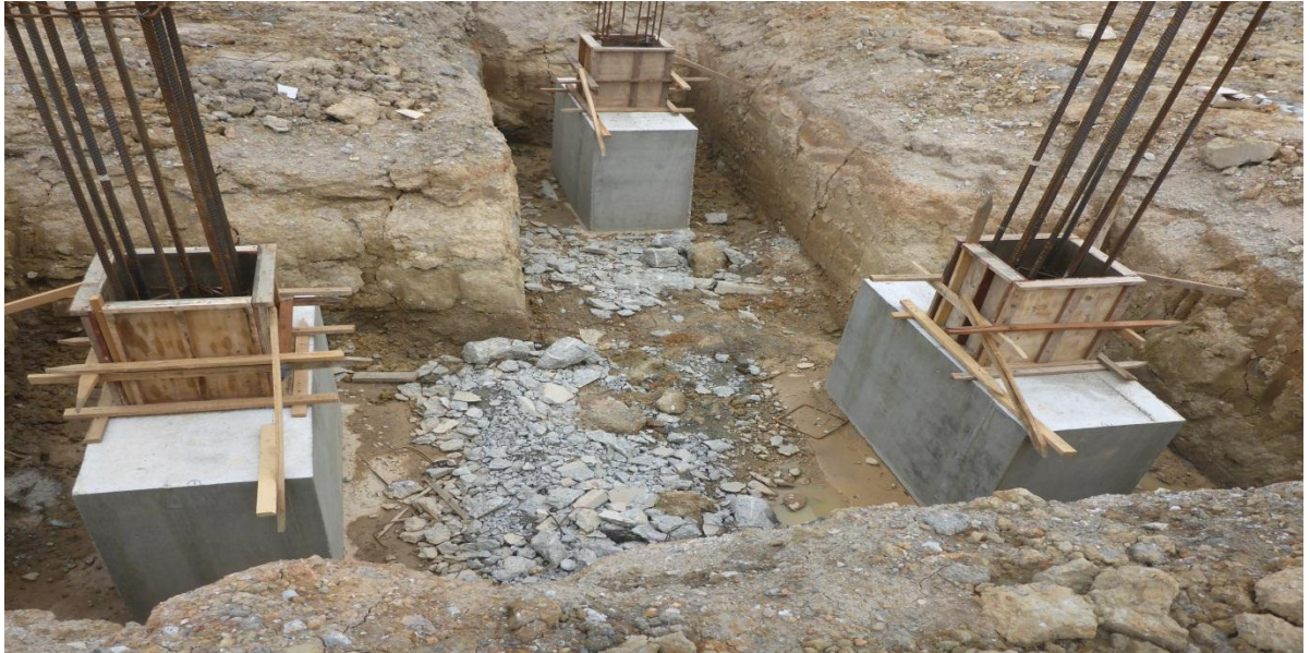
4.4 Kerja-kerja pembinaan sub- structure
