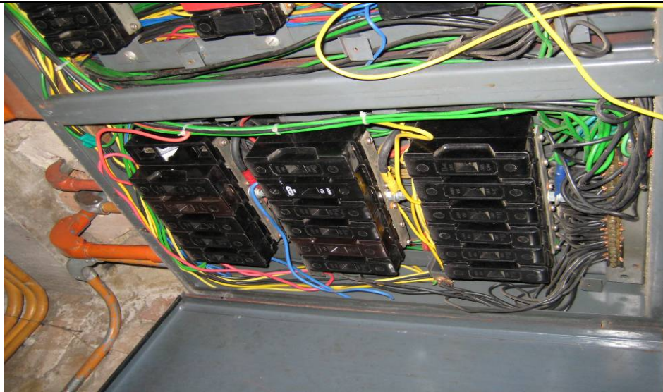
GAMBAR 1A mengganti baru Papan Suis Utama, Submain Kabel dan semua peralatan/perkakasan elektrik.
