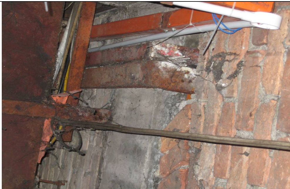
GAMBAR 21A mengganti baru Papan Suis Utama, Submain Kabel dan semua peralatan/perkakasan elektrik.
