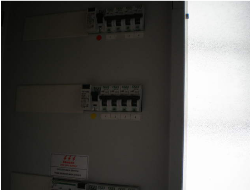
No 5 : Litar soket dan litar a/c bercampur dalam satu DB
