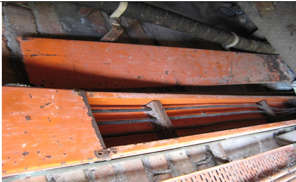
GAMBAR 19A Trunking usang dan berkarat. (Tingkat Bawah)
