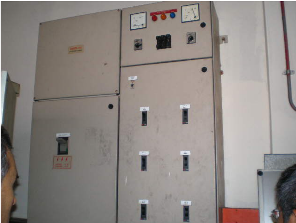
No 12 : BD yang mengedalikan motor lif juga perlu diganti kerana sudah lama
