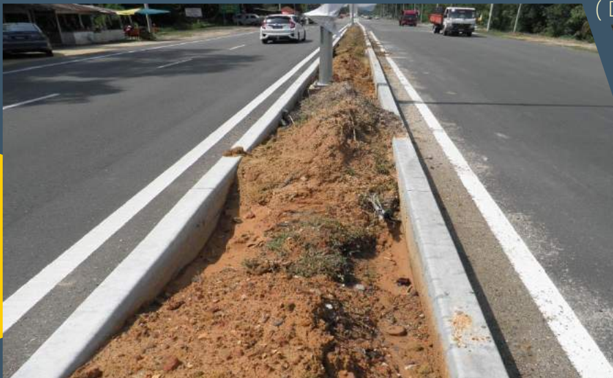
Kerja-Kerja Menambun Tanah Ke Dalam Median Di Meraga Beris ( Dari Awana Kijal - Persimpangan FT3/FT145 )
