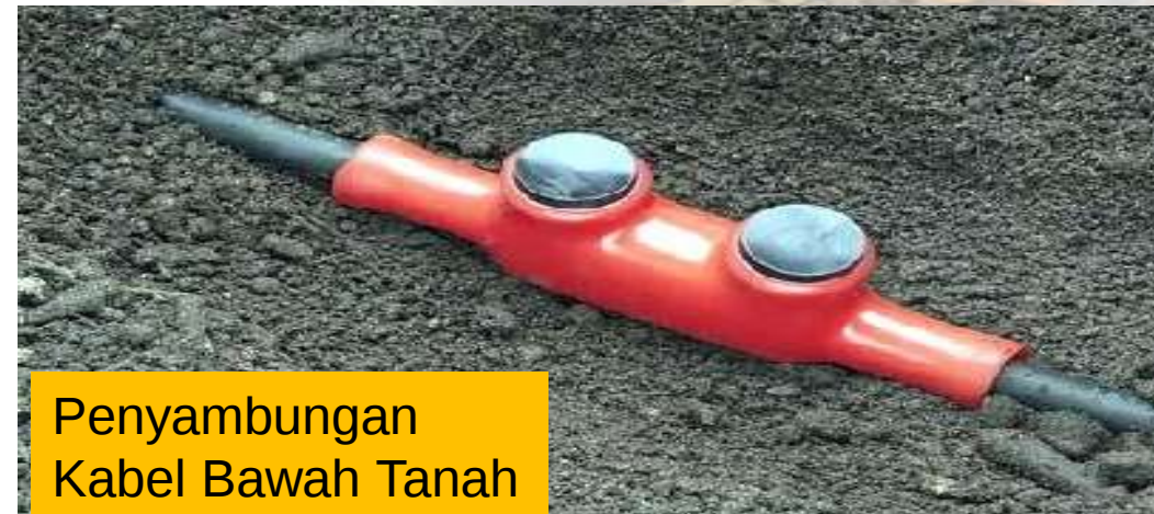
Kerja-kerja penaman kabel
