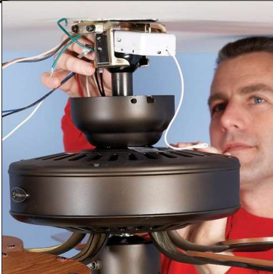
Pemasangan kipas siling
