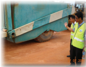
Rajah 4: Proof rolling dapat dijalankan ke atas setiap inci permukaan subgrade.
