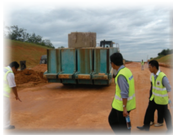
Rajah 6: Ujian proof rolling sedang dijalankan.
