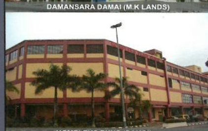
KOMPLEKS PKNS (BANGI)
