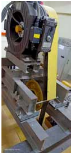
Mesin dan Motor Lif di Bilik Motor Lif
