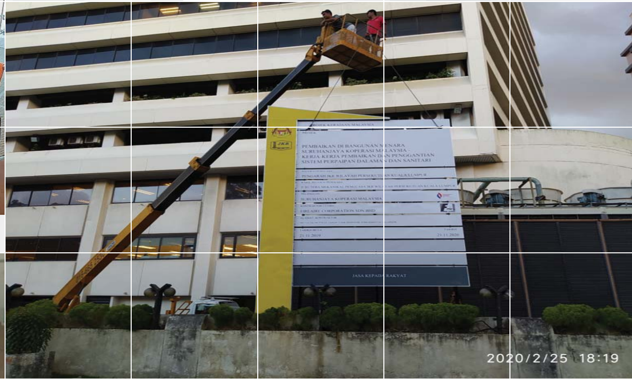
Pemasangan Papan Tanda (Peringkat Awal)
