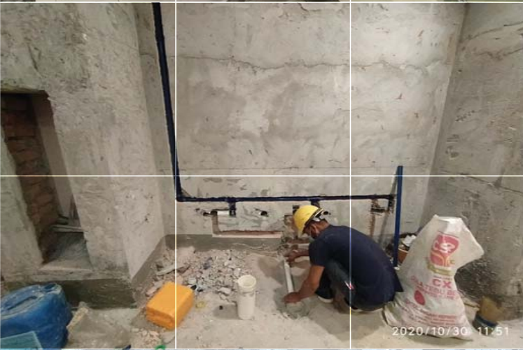
Pemasangan Paip Air Dalam & Sanitari
