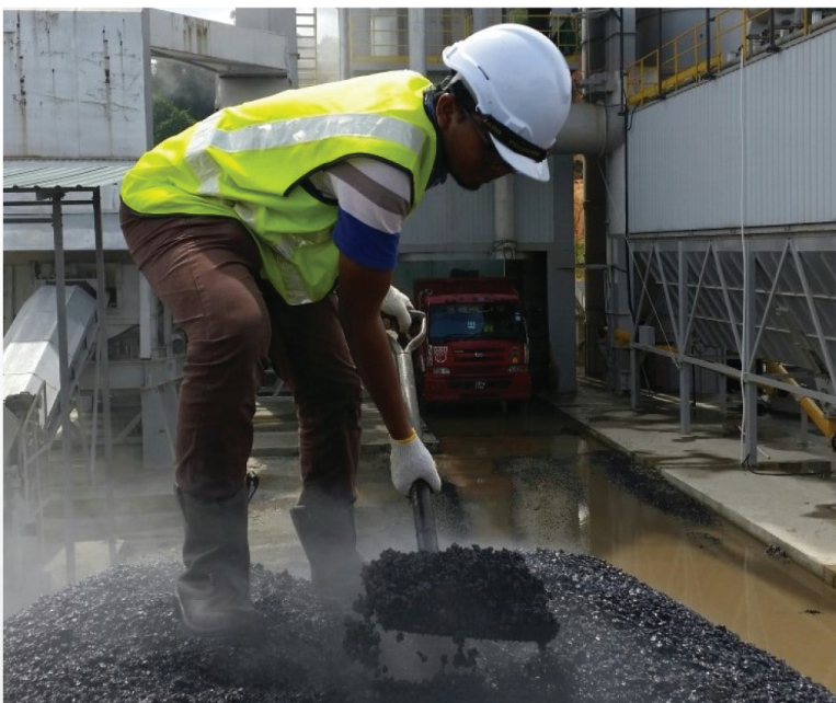
Scoop 100 mm di bawah permukaan.
