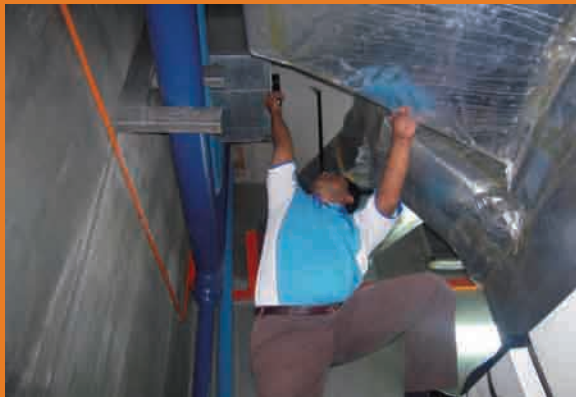
Mengambil bacaan kadar aliran udara luar
