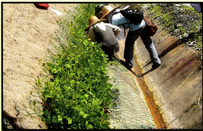
Pemantauan terhadap penanaman spesies Legum ditanam secara bantuan 'chain-link' dan juga hampanan fiber sabut kelapa.
