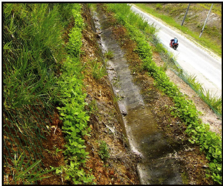
Legum ditanam secara konvensional pada cerun jenis batuan syal biasa serta dengan bantuan 'chain-link'.
