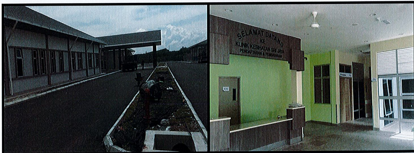
Bangunan Utama KK5
