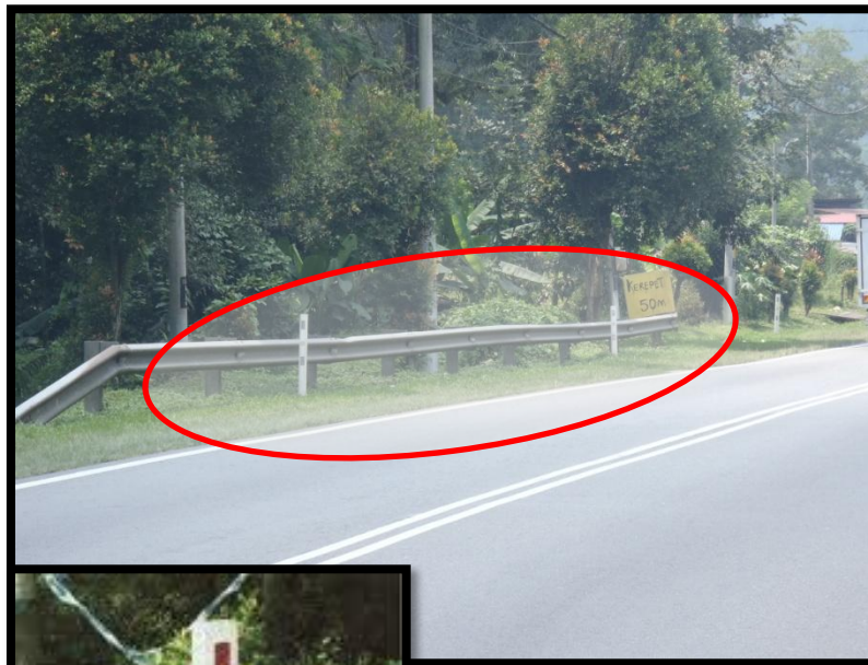
Tiang delineator dipasang di hadapan guardrail
