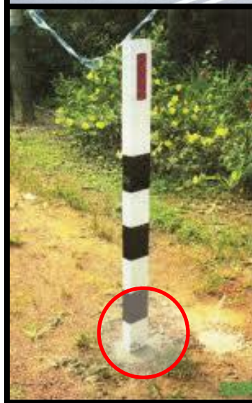
Tiang delineator dipasang di hadapan guardrail
