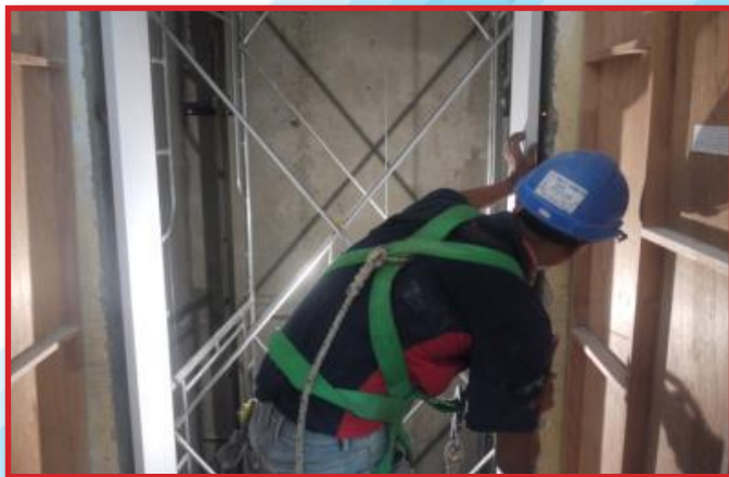
◀ Kerja memasang lift door jamb
