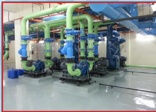
▲ Pump, piping dan fitting baru
