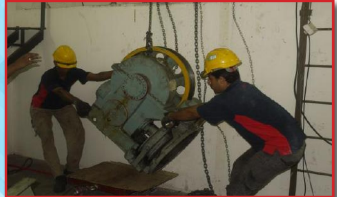
Kerja – kerja menanggal traction machine lif lama ▲
