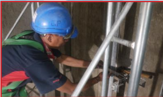
▲ Kerja pemasangan guiderail di dalam lift shaft
